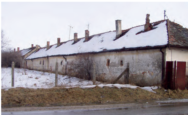
Dodnes sa zachovala obytná budova s bytmi deputátnikov. Foto: (autor)
