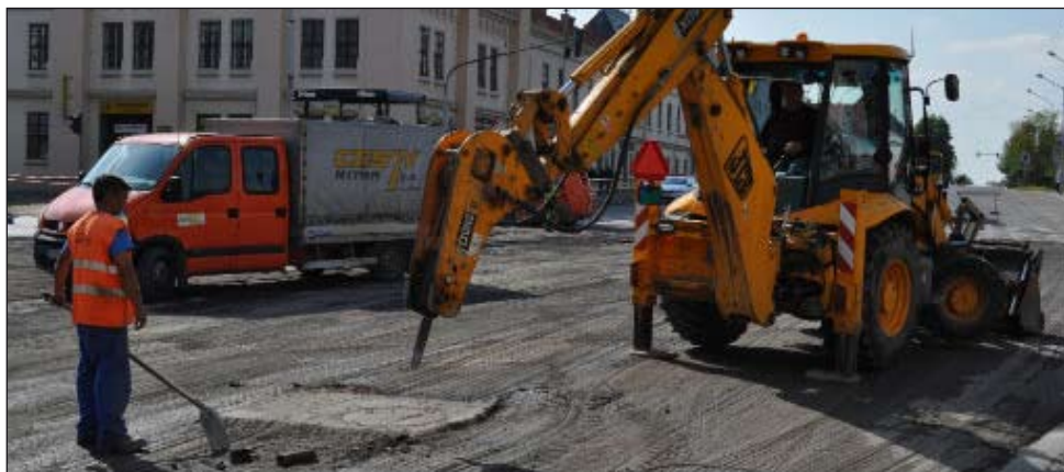
Počas víkendu 12. a 13. apríla sa do vozovky „zahryzli“ rôzne stavebné stroje.
