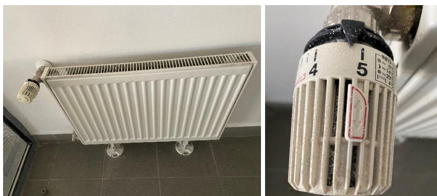
Obr. 5: Vykurovacie telesá, termostatické hlavice
