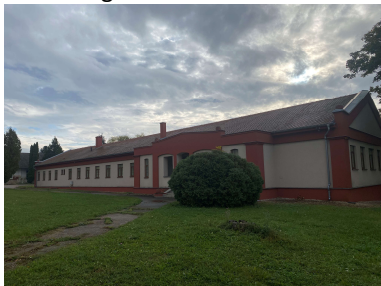
Administratívne budovy Archeologického ústavu SAV
