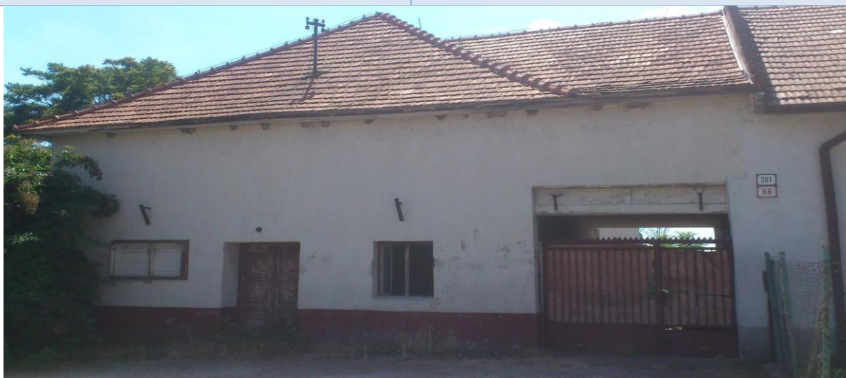
KD Janíkovce Hlavná (budova odpojená od energií)
