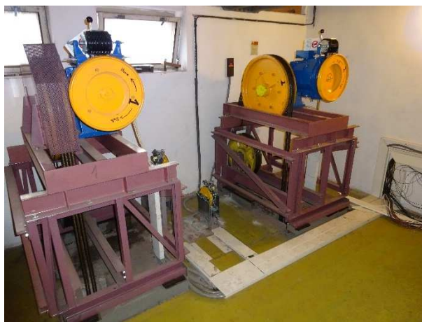
Obrázok 20 – Strojovňa výťahu
