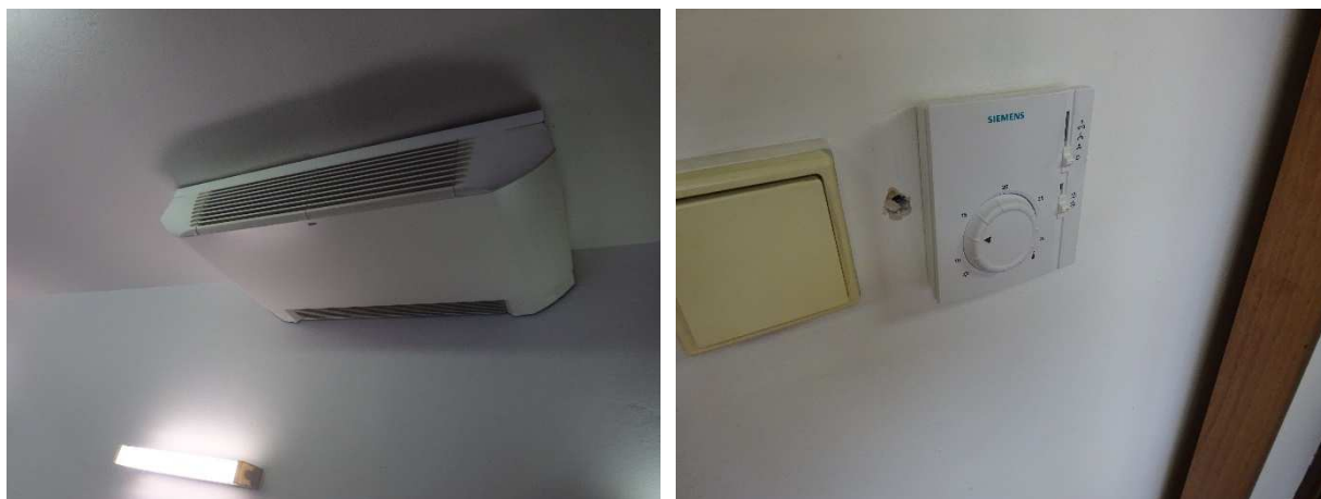
Obrázok 19 – Fancoily v kanceláriach s ovládaním
