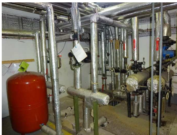
Obrázok 8 – Rozdeľovače a zberače vykurovacej vody
