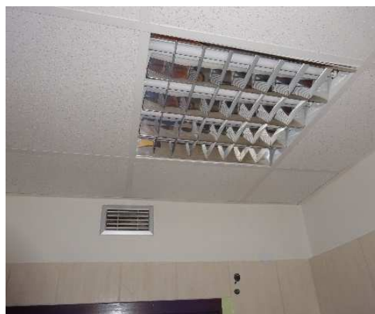
Obrázok 32 – Osvetlenie na toaletách
