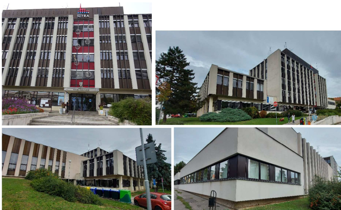
Obrázok 5 – Súčasný stav obalového plášťa budovy MsÚ v Nitre
