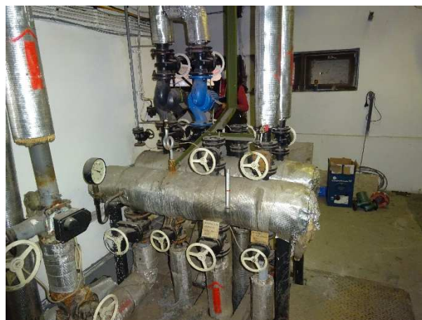
Obrázok 8 – Rozdeľovače a zberače vykurovacej vody
