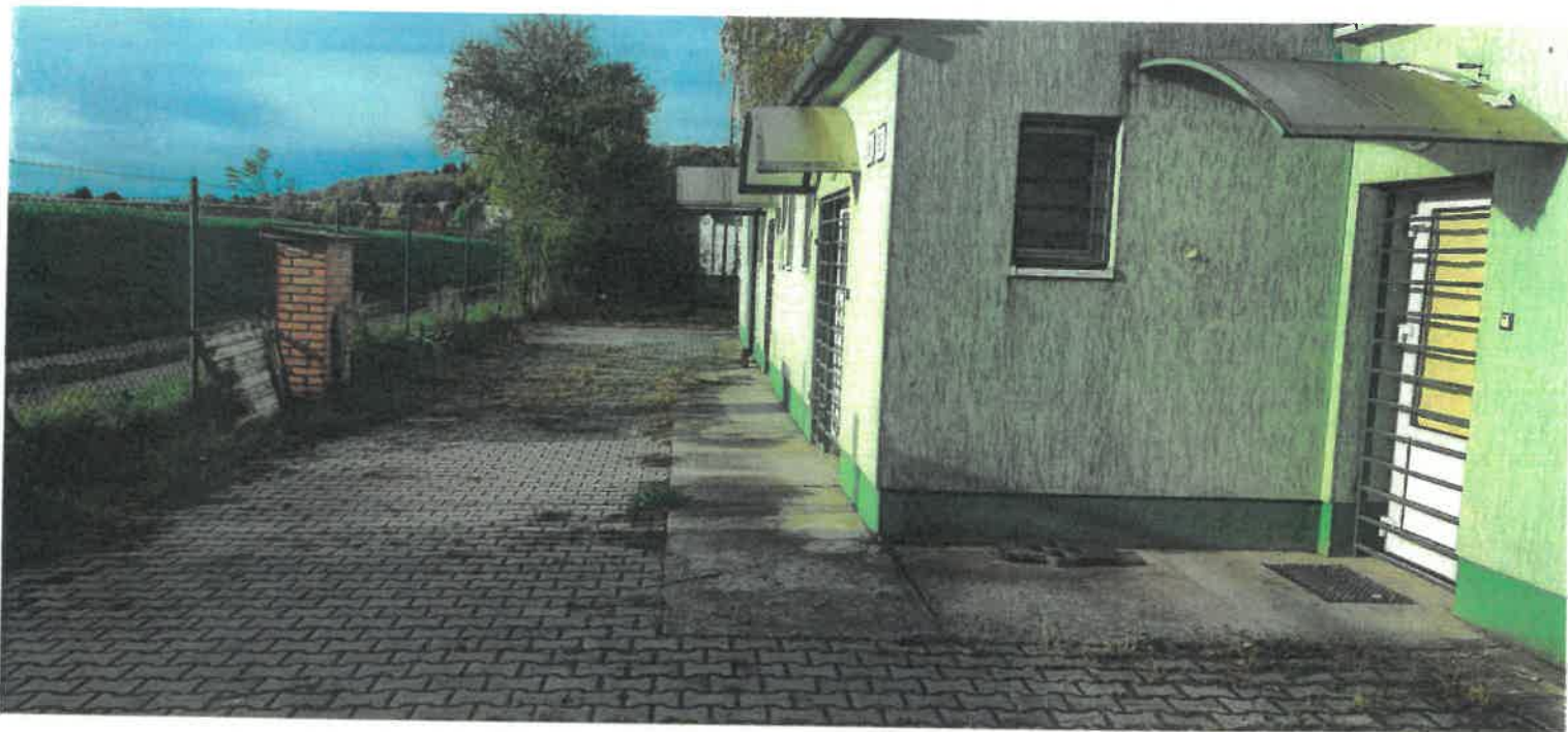
Pozemok pred budovou, ľavá strana
