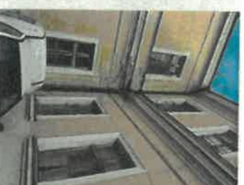
Pohlady na átriový dver-zámková diaľka-opevnenie plocha, výškať fasády opadané omietka
