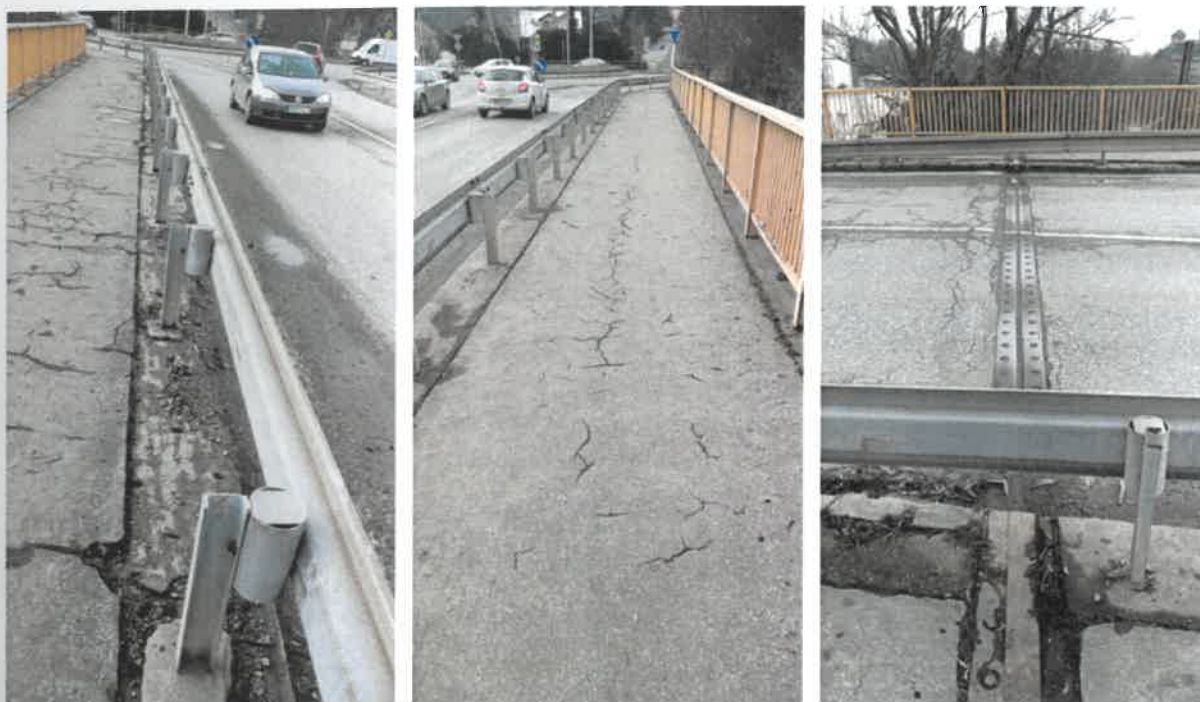
Obrázok 4: mostný zvršok, príslušenstvo mosta a mostný záver
