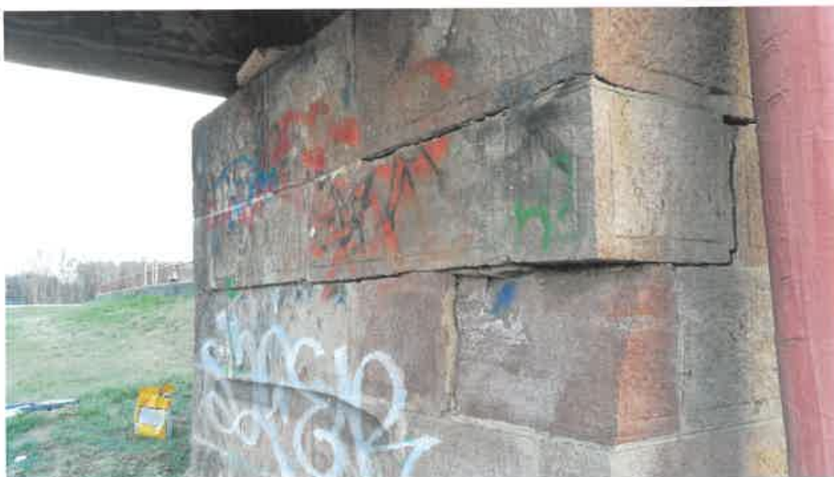
Obrázok 22: Pravobrežná opora – poruchy muriva
