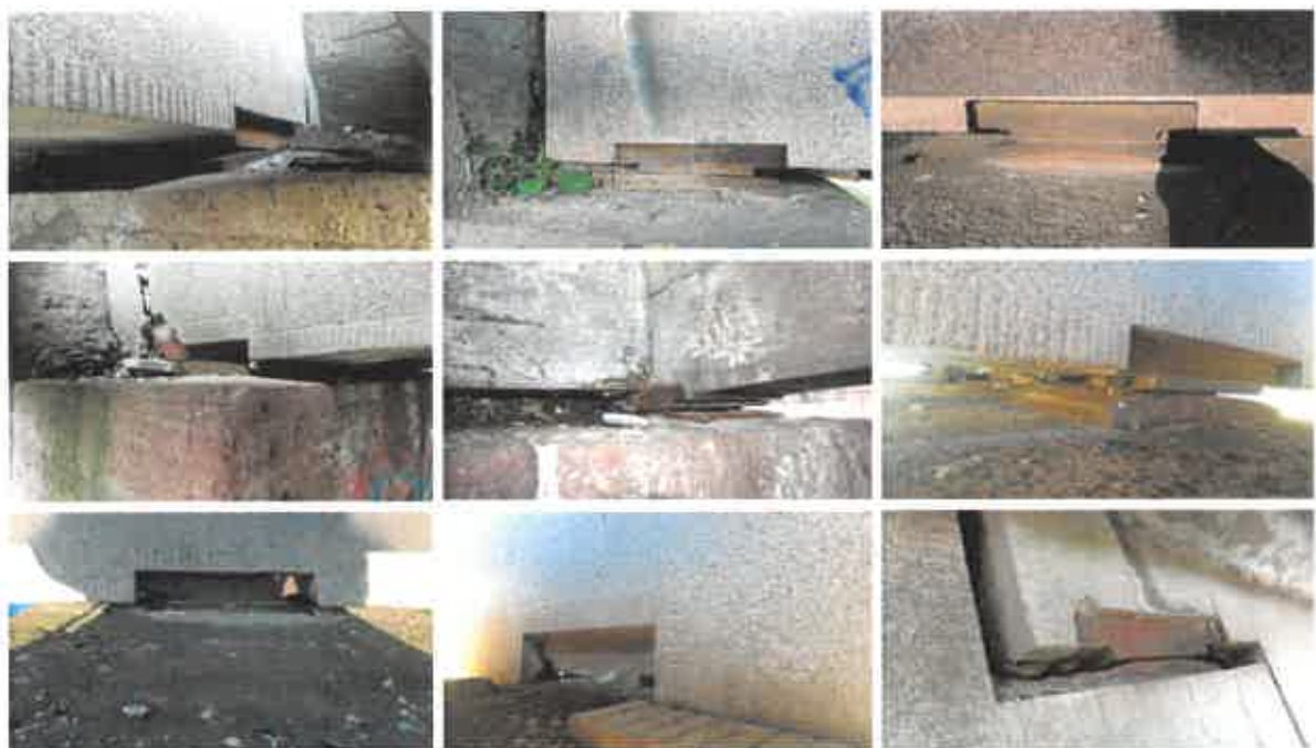
Obrázok 25: Ložiská na nosnej konštrukcii
