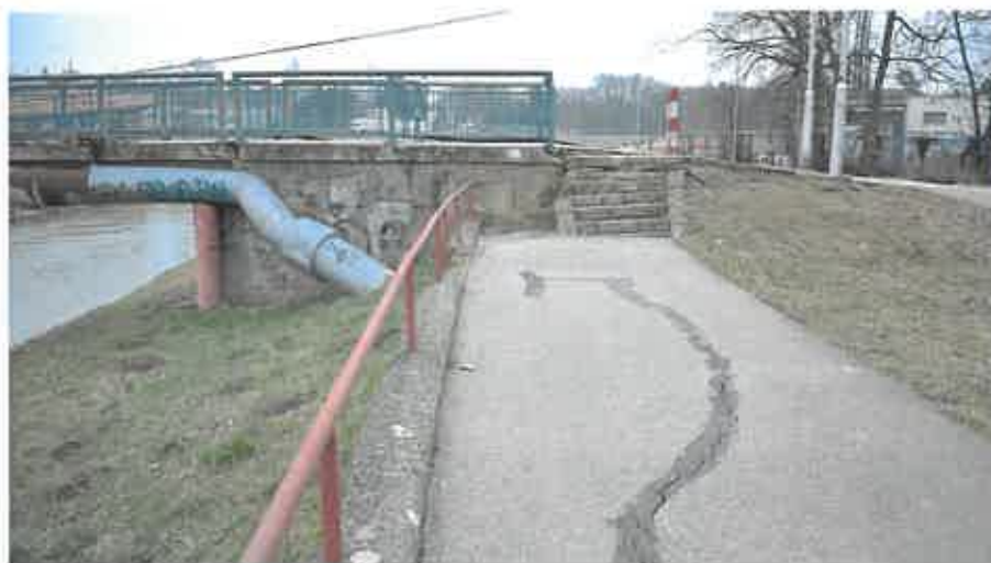
Obrázok 7: Trhlina v chodníku ako dôsledok zosúvania svahu
