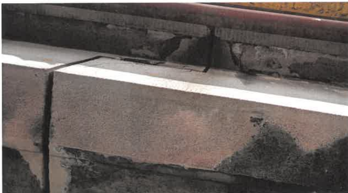
Obrázok 61: Kĺb v nosnej konštrukcii – v blízkosti piliera č. 1 (III)
