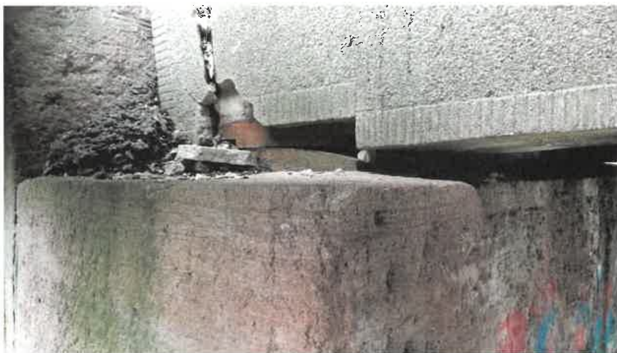
Obrázok 44: Ložisko na ľavobrežnej opore (I)
