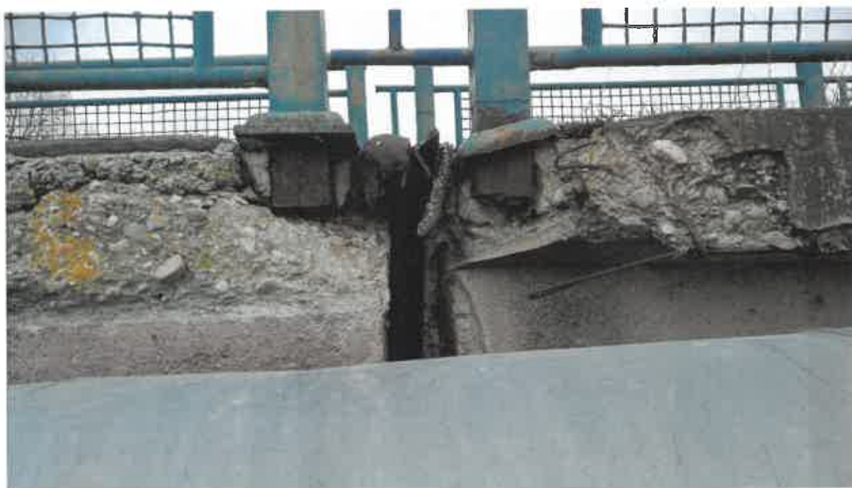
Obrázok 78: Kotvenie zábradlia (I)
