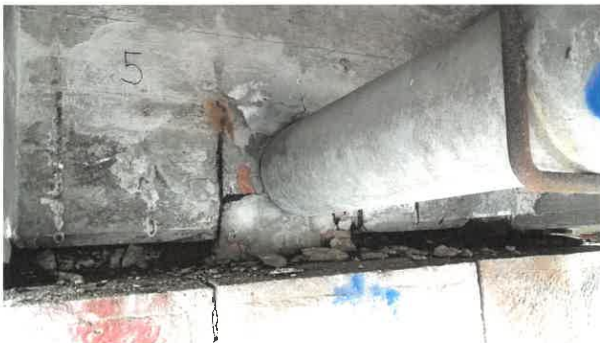
Obrázok 43: Úložný prah na pravobrežnej opore
