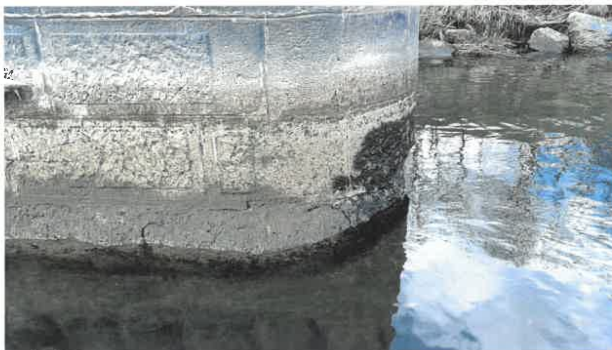
Obrázok 30: Pilier č. 1 – betónová vyrovnávacia vrstva medzi základom a prvou radou kvádrov (I)
