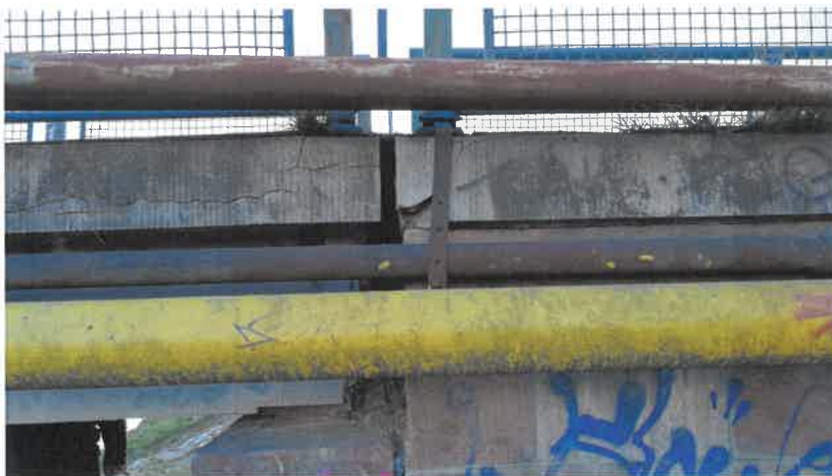
Obrázok 71: Dilatačná medzera – ľavobrežná opora
