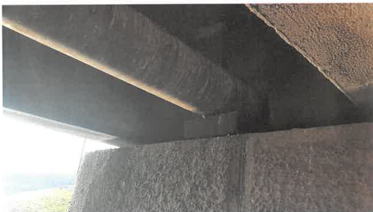
Obrázok 40: Pilier č. 2 – úložný prah
