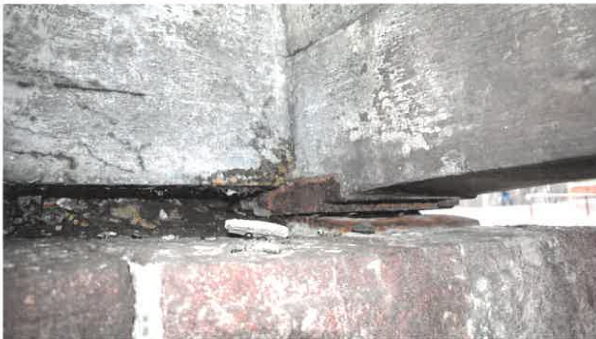
Obrázok 45: Ložisko na ľavobrežnej opore (II)
