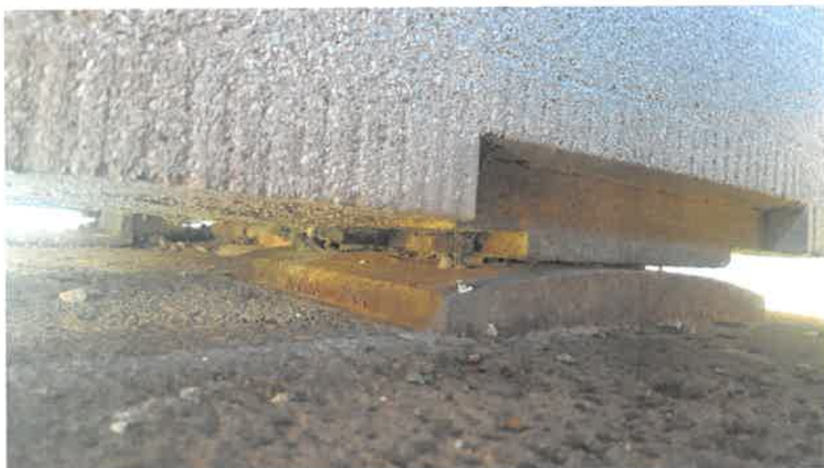
Obrázok 50: Ložisko na pilieri č. 2 (II)
