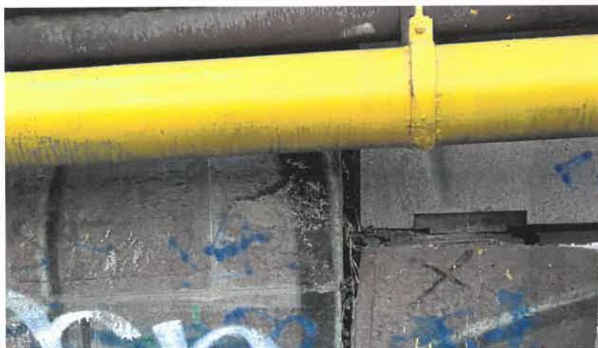
Obrázok 72: Dilatačná medzera – pravobrežná opora
