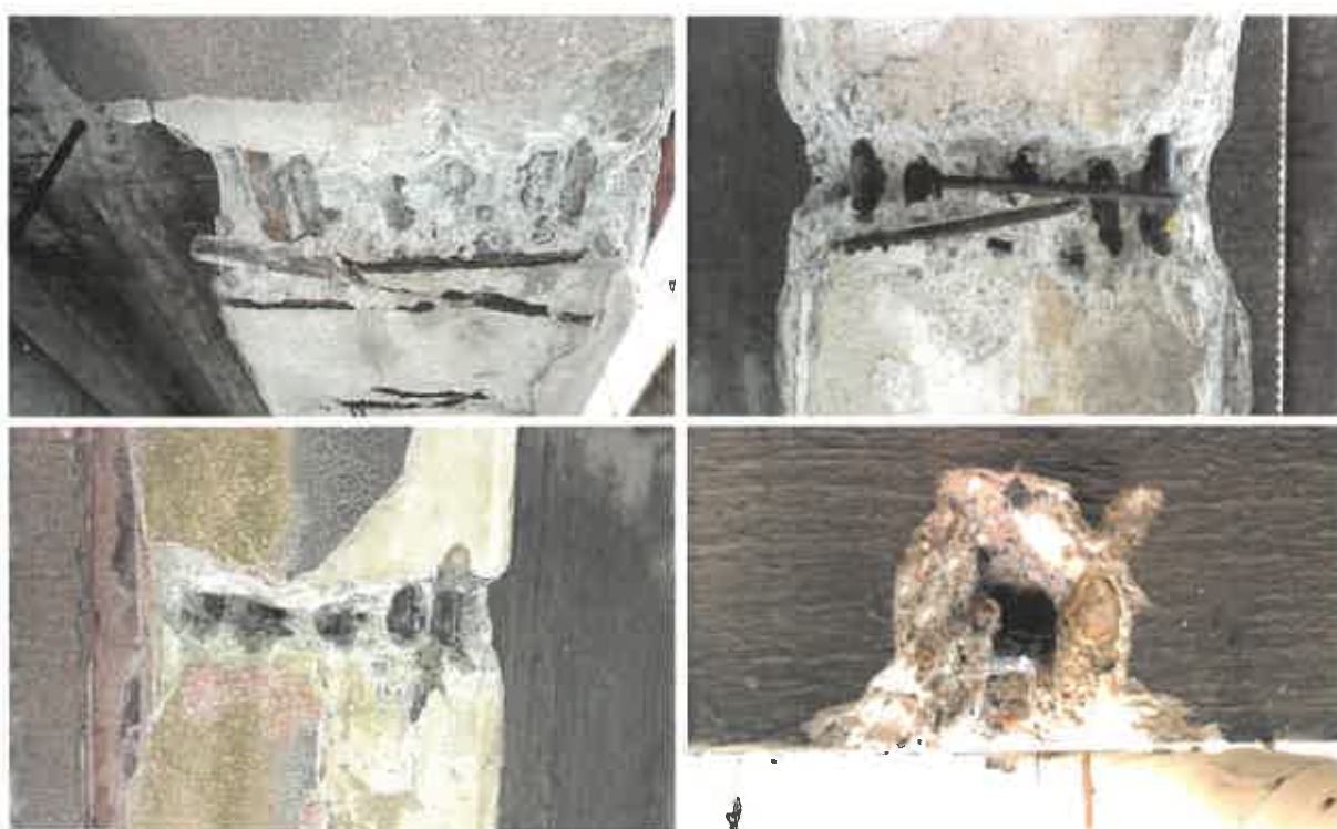
Obrázok 21: Miesta, kde bola obnažená výstuž – hlavný trám v poli č. 2, trámy v poli č.3, medziláhľý priečnik.
