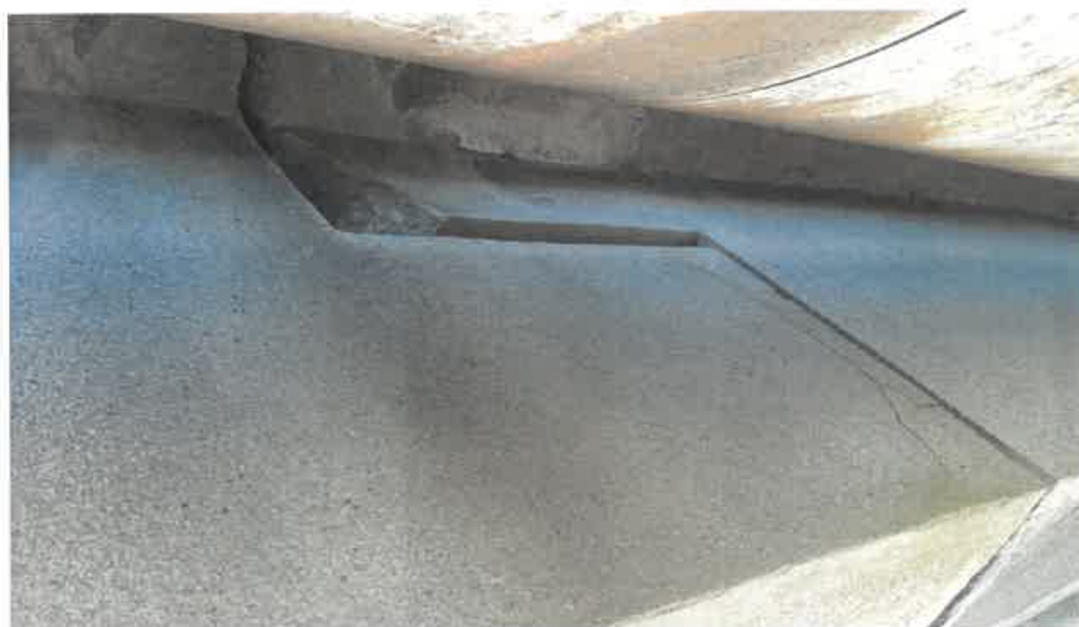
Obrázok 62: Kĺb v nosnej konštrukcii – v blízkosti piliera č. 1 (IV)
