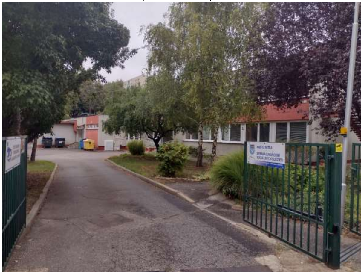
Príloha 1: Budova Baničova 522/12, Nitra – aktuálny stav rok 2024
