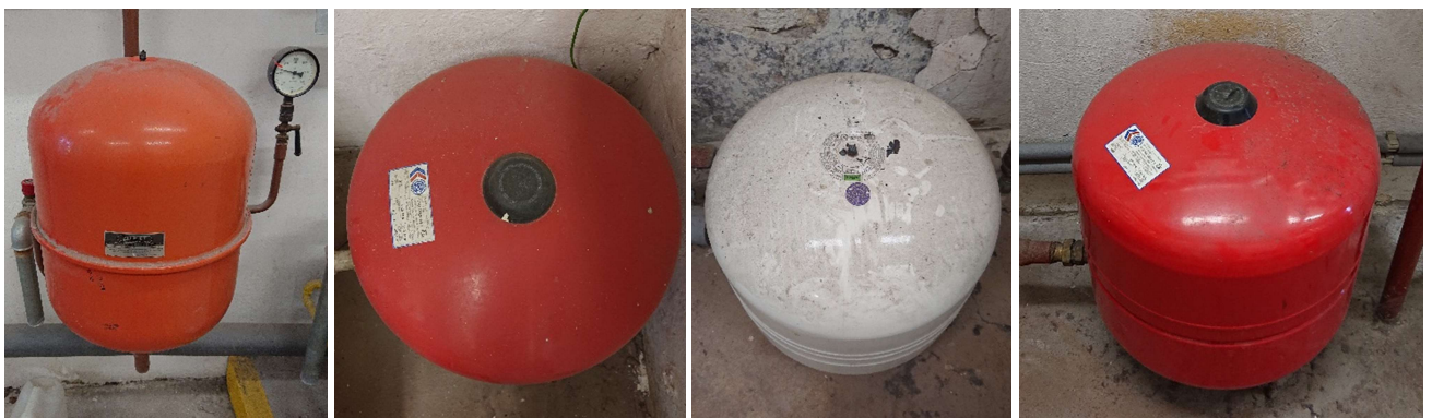
Obr. 3: Tlakové expanzné nádoby
