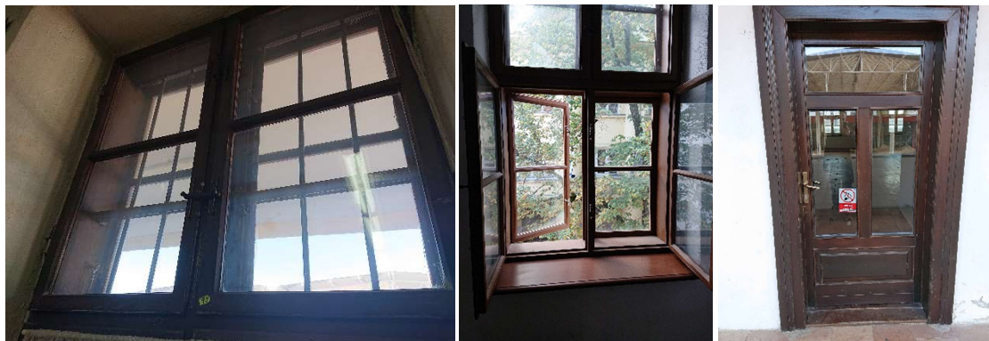
Obr. 20: Otvorové konštrukcie (naľavo pôvodné okno s mrežou, v strede replika okna)
