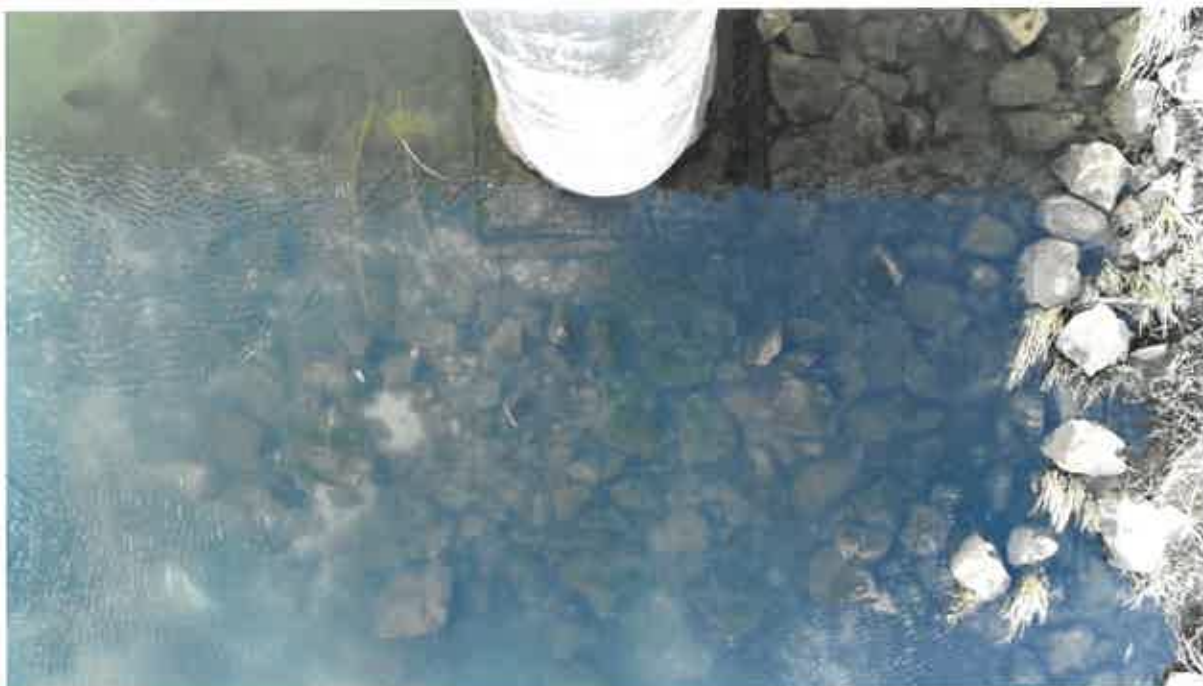
Obrázok 33: Pilier č. 1 – pohľad z lávky (povodná strana)
