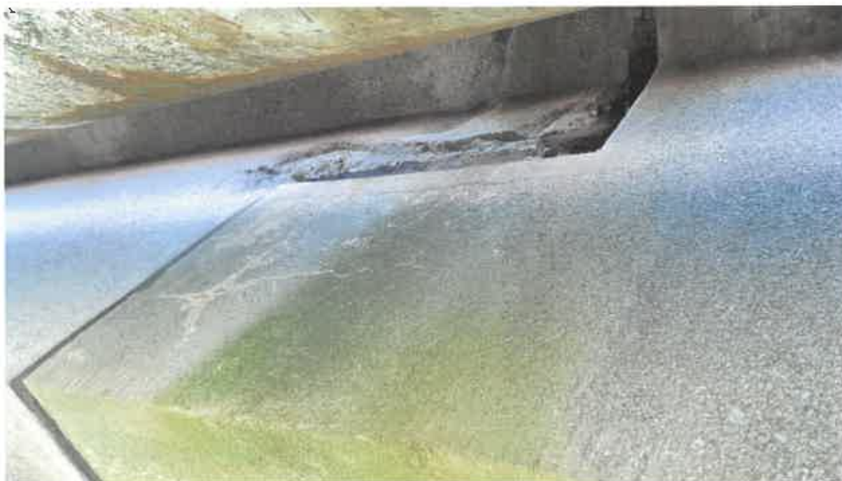
Obrázok 63: Kĺb v nosnej konštrukcii – v blízkosti piliera č. 2 (I)
