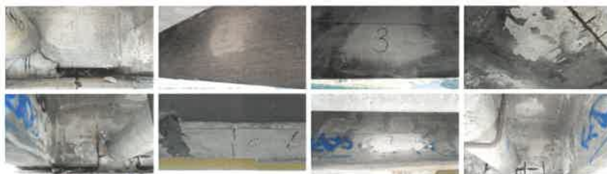
Obrázok 15: Miesta pre nedeštruktívne zisťovanie pevnosti betónu
