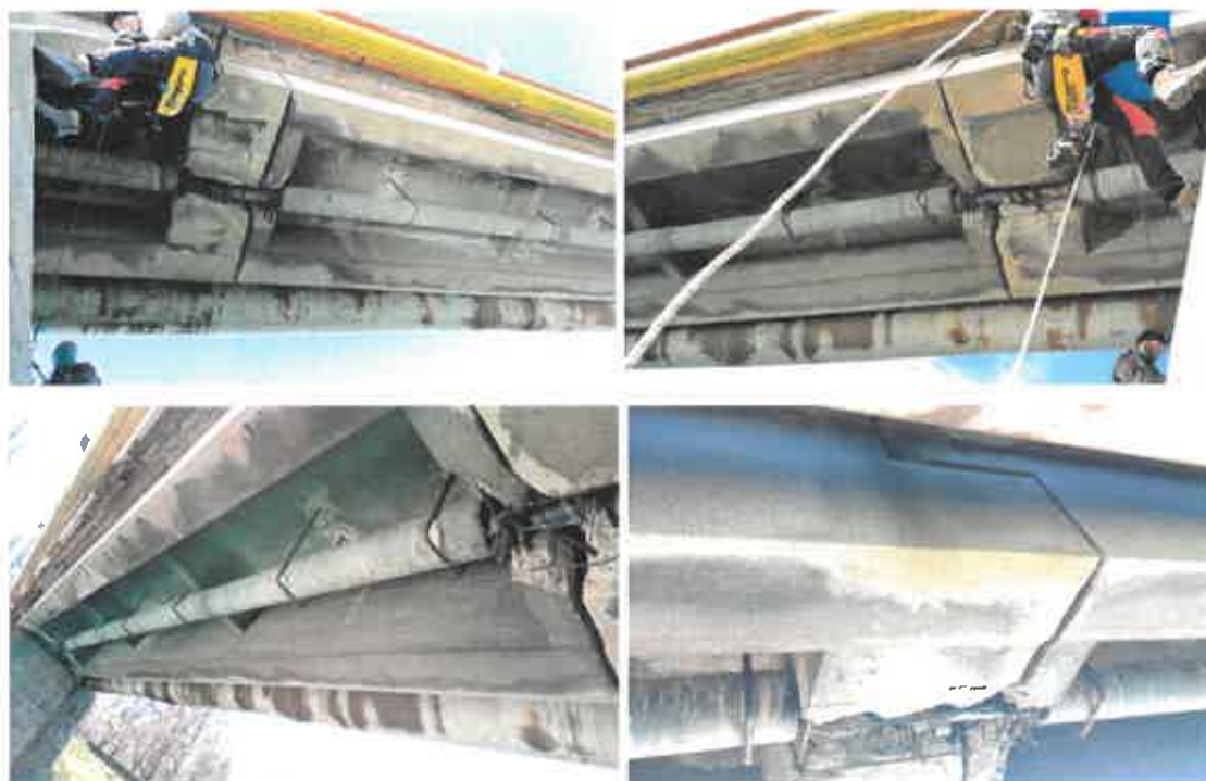
Obrázok 22: Pohľad na spodnú stranu nosnej konštrukcie lávky
