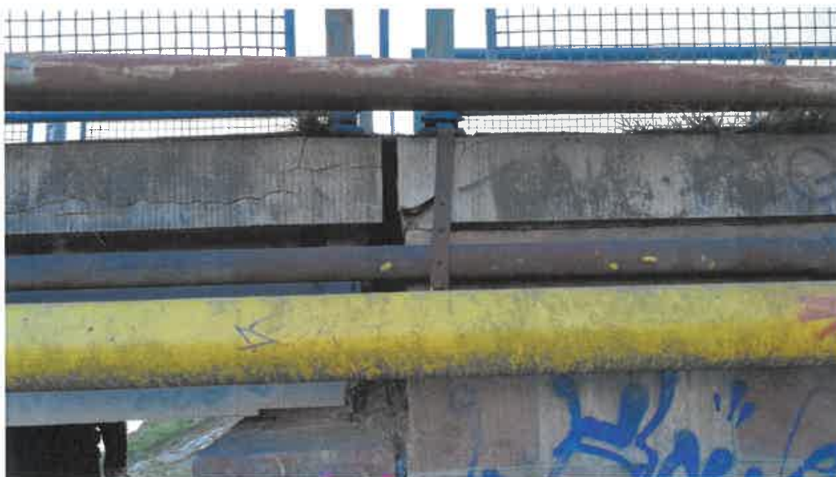
Obrázok 71: Dilatačná medzera – ľavobrežná opora
