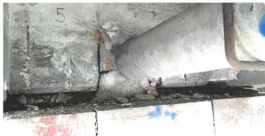
Obrázok 24: Znečistený úložný prah na opore
