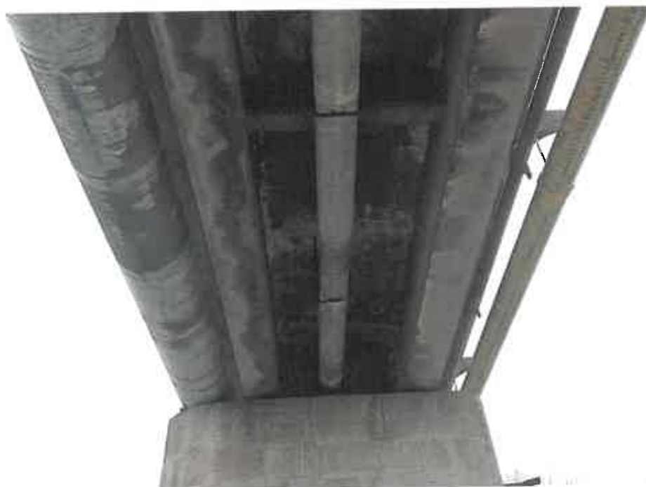
Obrázok 54: Hlavná nosná konštrukcia lávky (IV)
