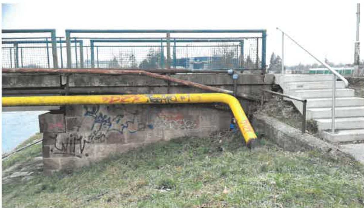
Obrázok 24: Ľavobrežná opora s krídlom (strana výtoku)
