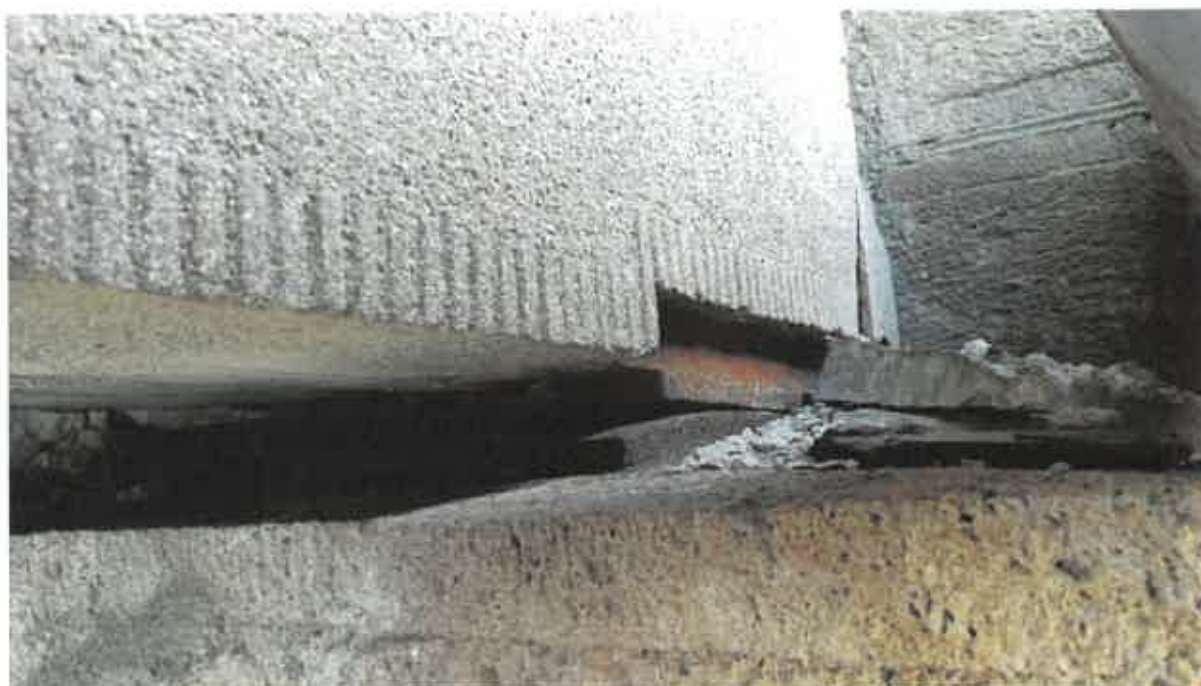
Obrázok 42: Ložisko na pravobrežnej opore (II)
