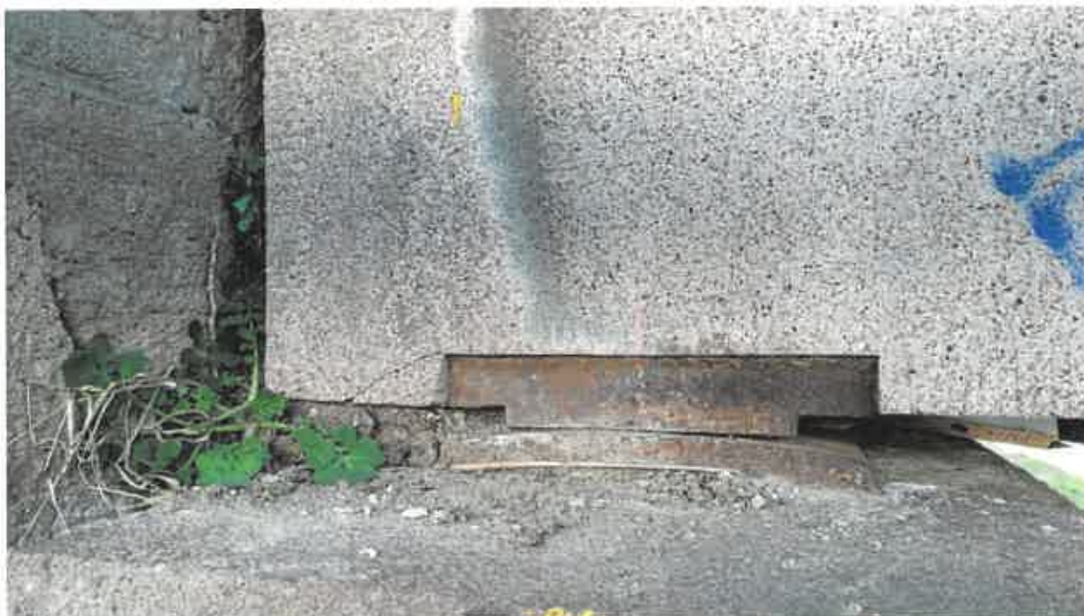
Obrázok 41: Ložisko na pravobrežnej opore (I)
