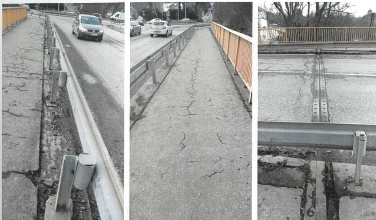
Obrázok 4: mostný zvršok, príslušenstvo mosta a mostný záver
