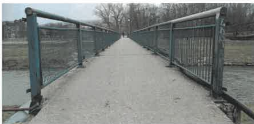
Obrázok 27: Chodník z liateho asfaltu
