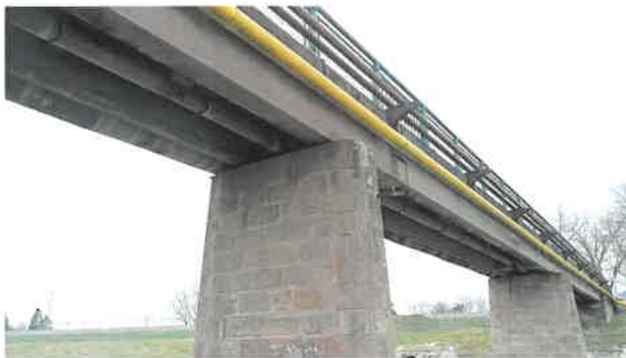
Obrázok 13: Pohľad na hlavnú nosnú konštrukciu lávky
