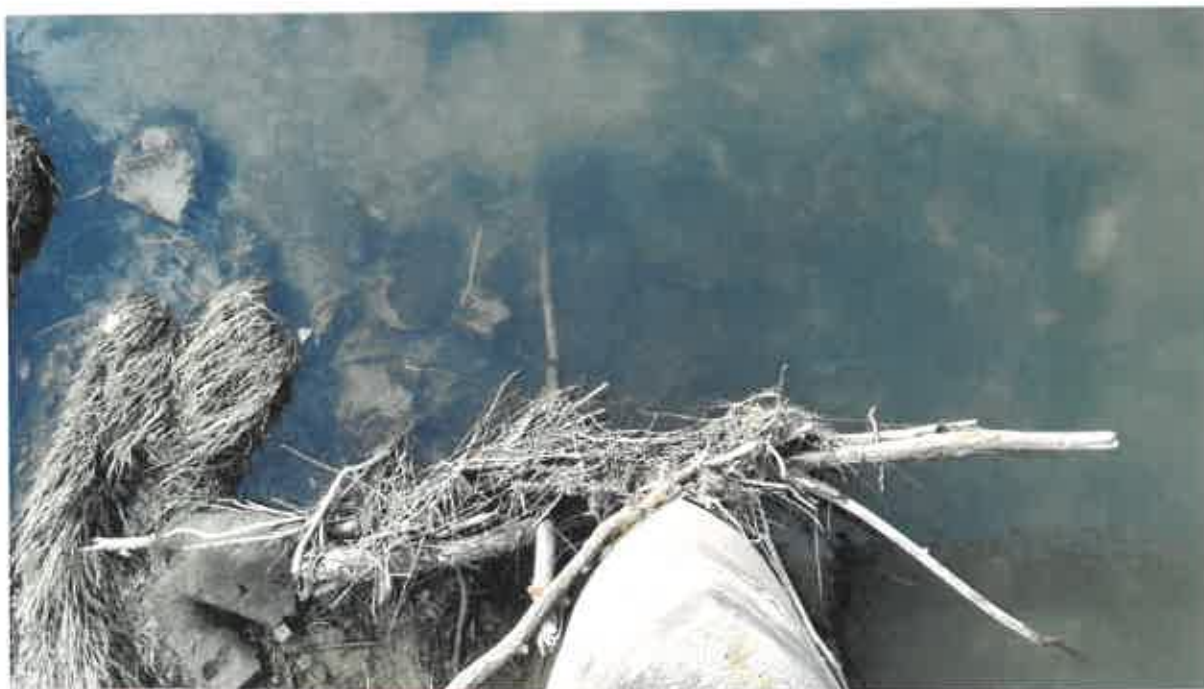
Obrázok 38: Pilier č. 2 – pohľad z lávky (návodná strana)
