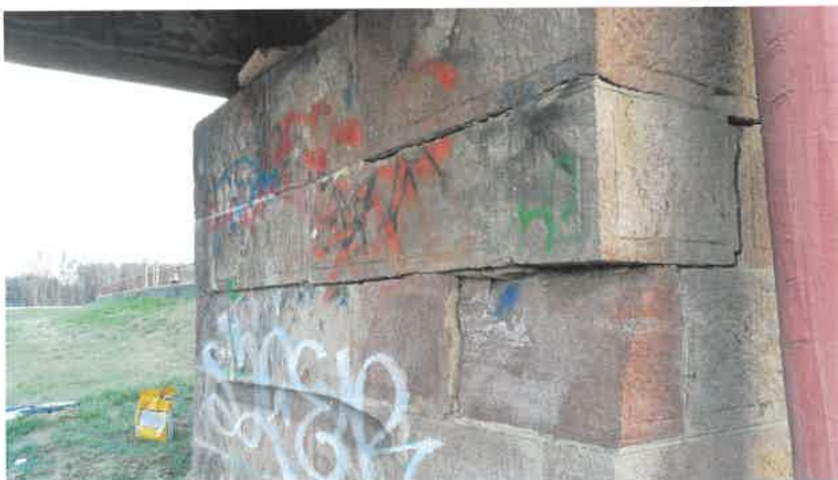
Obrázok 22: Pravobrežná opora – poruchy muriva
