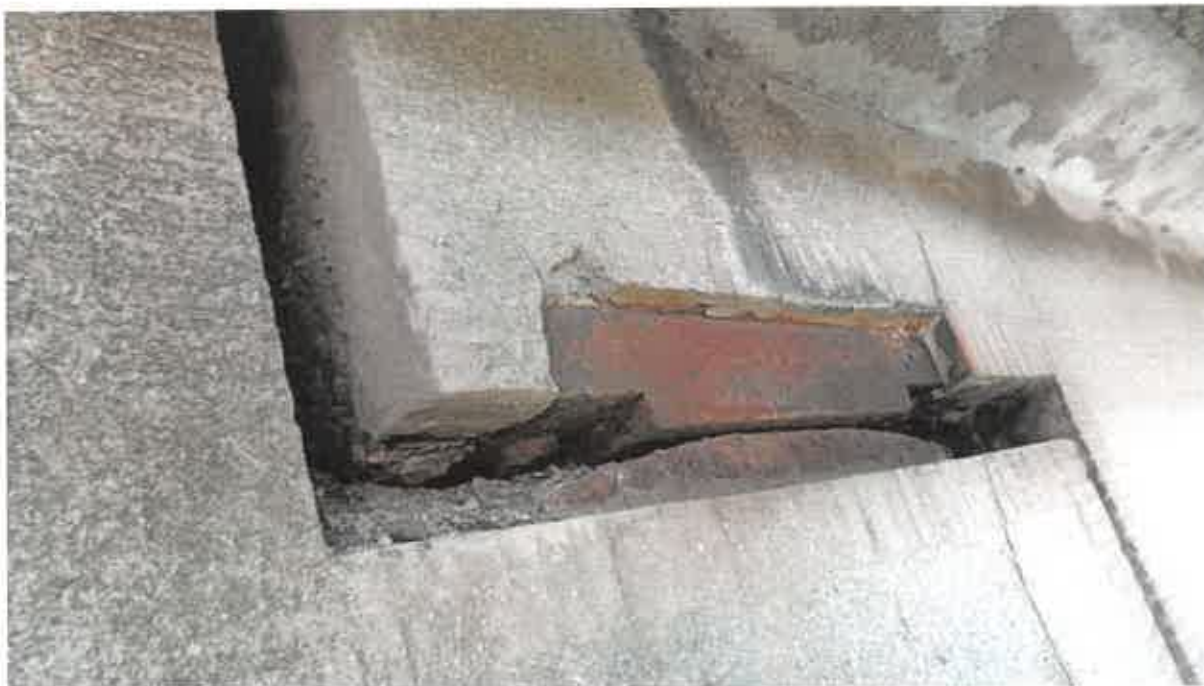
Obrázok 65: Kĺb v nosnej konštrukcii – v blízkosti piliera č. 2 (III)
