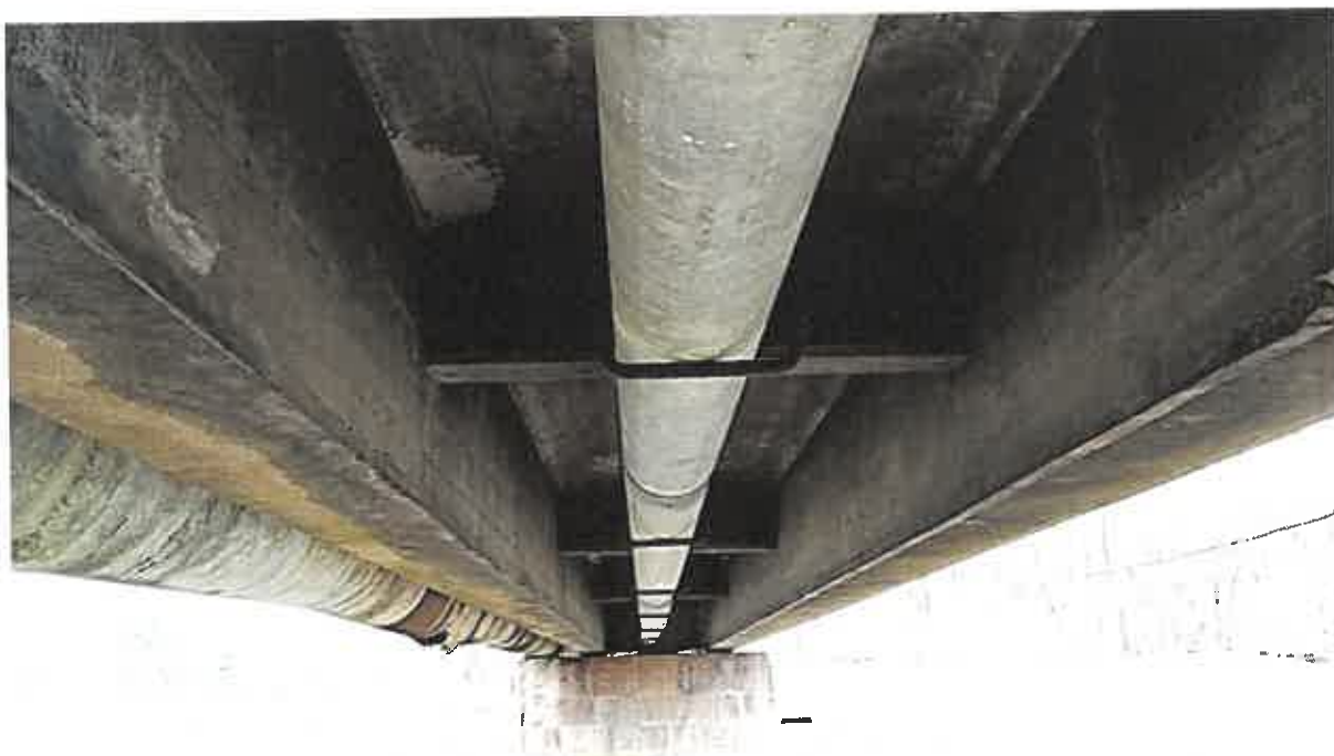
Obrázok 53: Hlavná nosná konštrukcia lávky (III)
