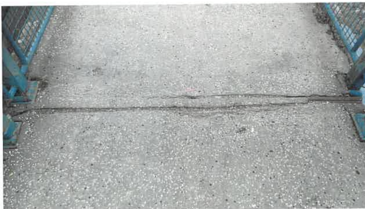
Obrázok 67: Mostný záver – ľavobrežná opora
