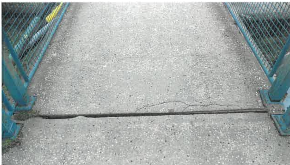
Obrázok 70: Mostný záver – pravobrežná opora
