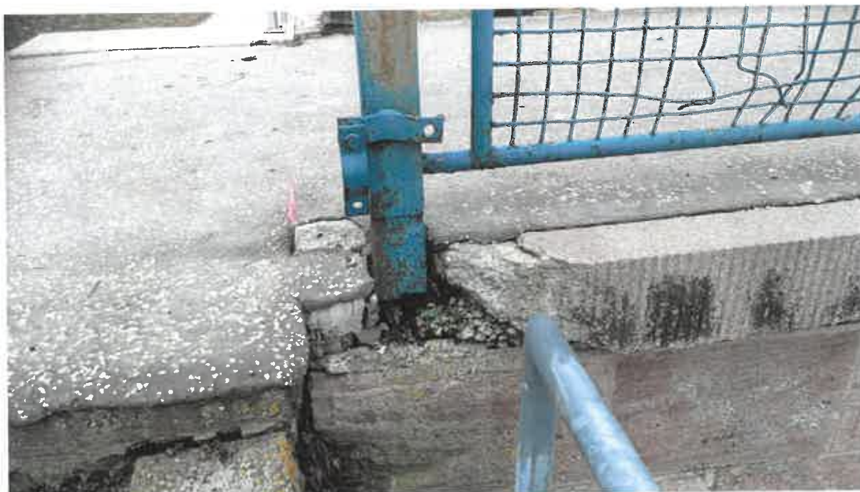
Obrázok 79: Kotvenie zábradlia (II)
