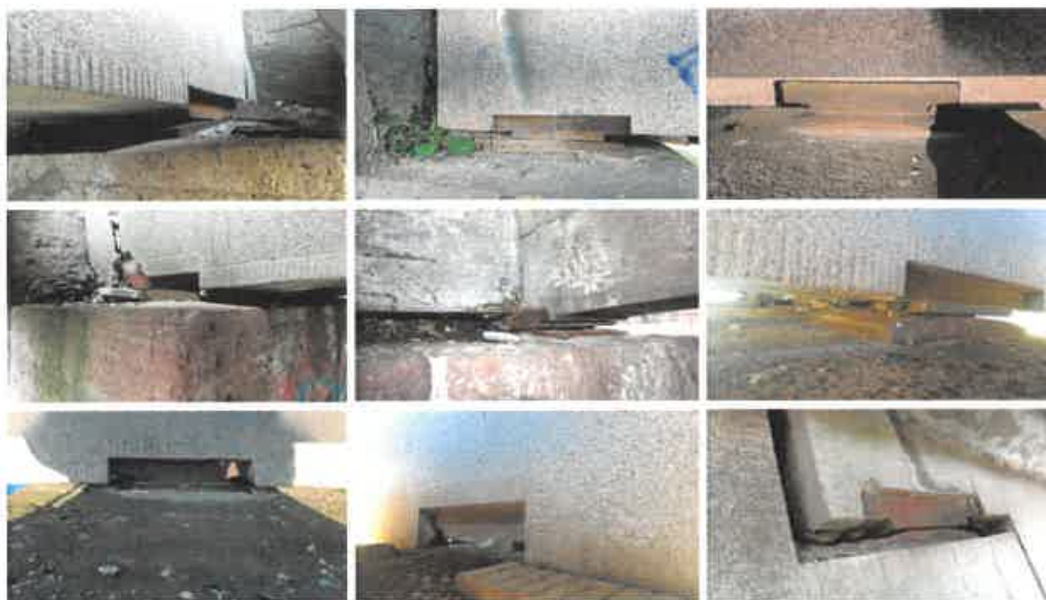
Obrázok 25: Ložiská na nosnej konštrukcii
