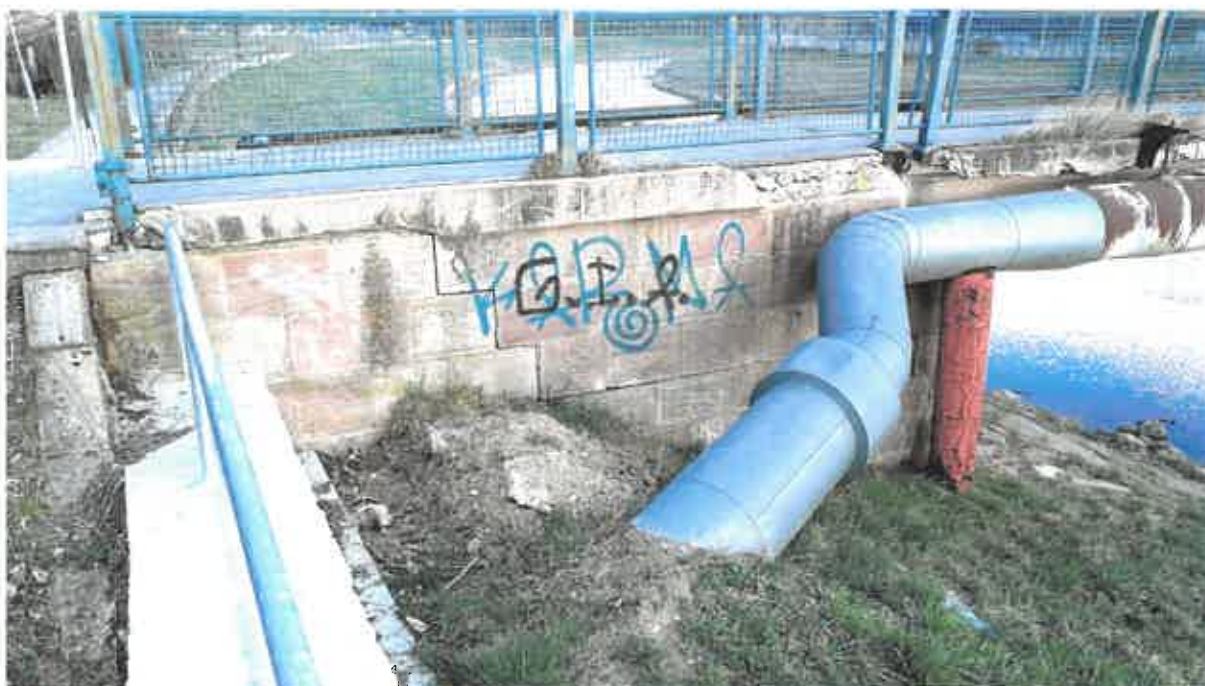
Obrázok 25: Ľavobrežná opora s krídlom (strana vtoku)
