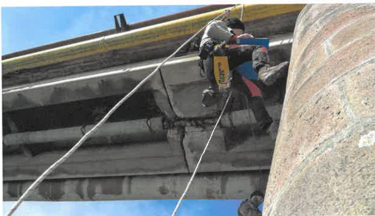
Obrázok 56: Hlavná nosná konštrukcia lávky (VI)
