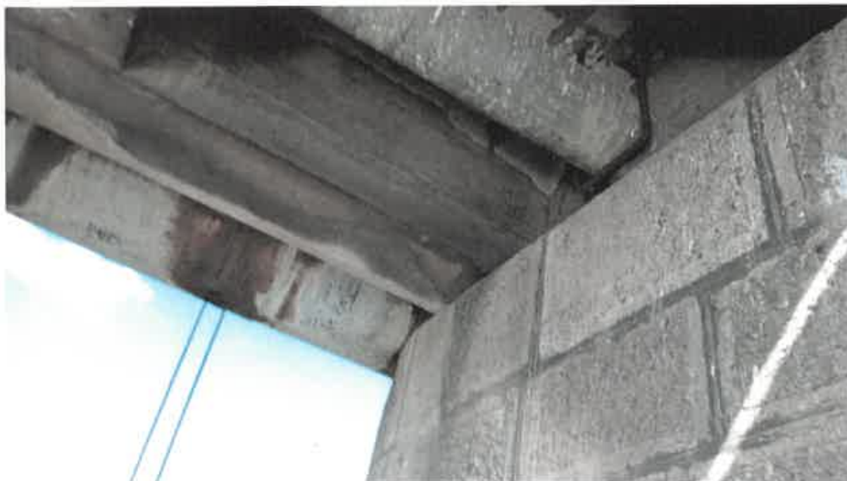
Obrázok 34: Pilier č. 1 – úložný prah
