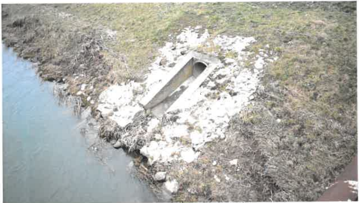
Obrázok 11: Vyústenie potrubia na ľavom brehu koryta pri lávke
