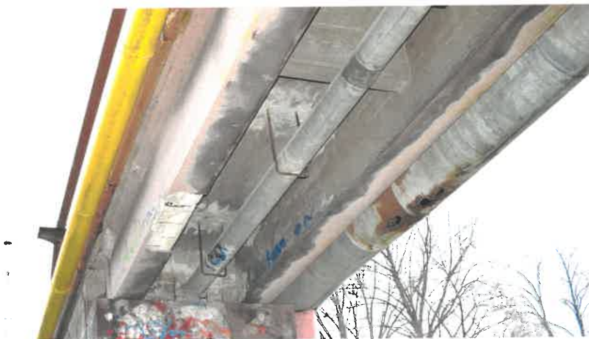
Obrázok 52: Hlavná nosná konštrukcia lávky (II)
