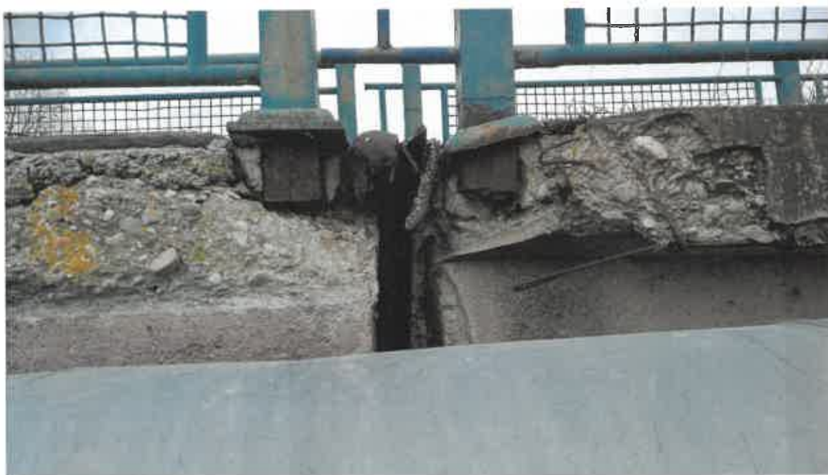
Obrázok 78: Kotvenie zábradlia (I)
