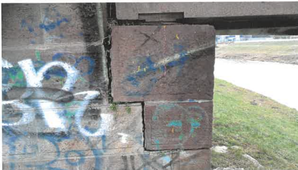
Obrázok 21: Pravobrežná opora – odtrhnutý úložný prah
