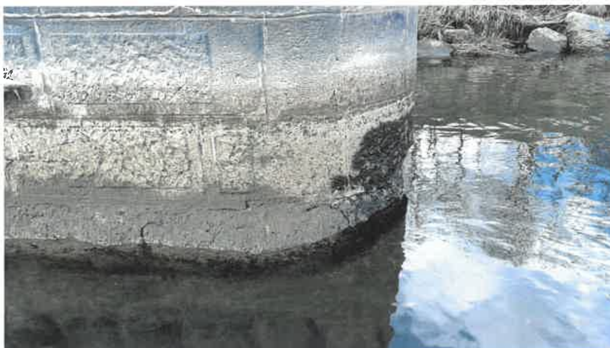
Obrázok 30: Pilier č. 1 – betónová vyrovnávacía vrstva medzi základom a prvou radou kvádrov (I)
