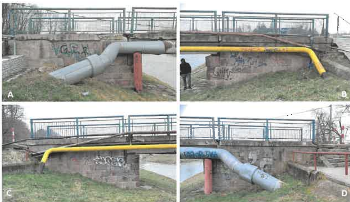
Obrázok 9: Pohľad na opory a krídla (A-l'avobrežná opora - návodná strana; B-l'avobrežná opora - povodná strana; C-pravobrežná opora - povodná strana; D-pravobrežná opora - návodná strana)
