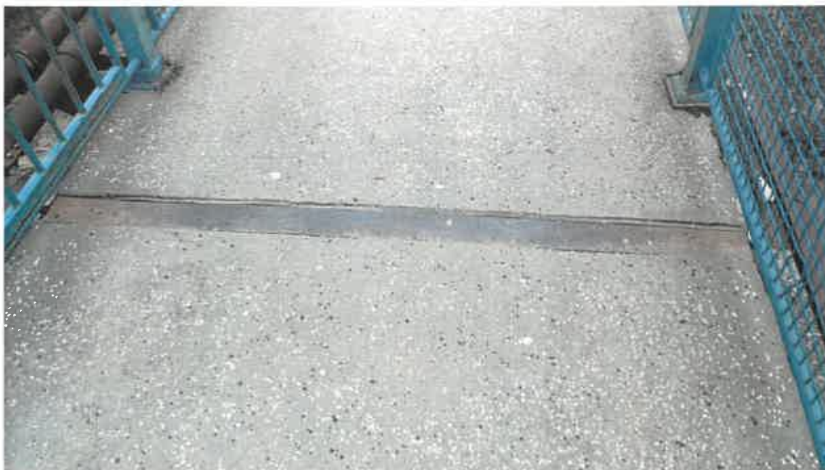
Obrázok 69: Mostný záver – kĺb v NK bližšie ku pilieru č. 2
