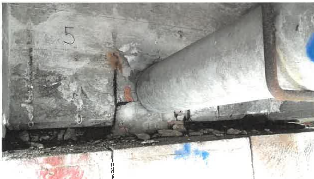
Obrázok 43: Úložný prah na pravobrežnej opore
