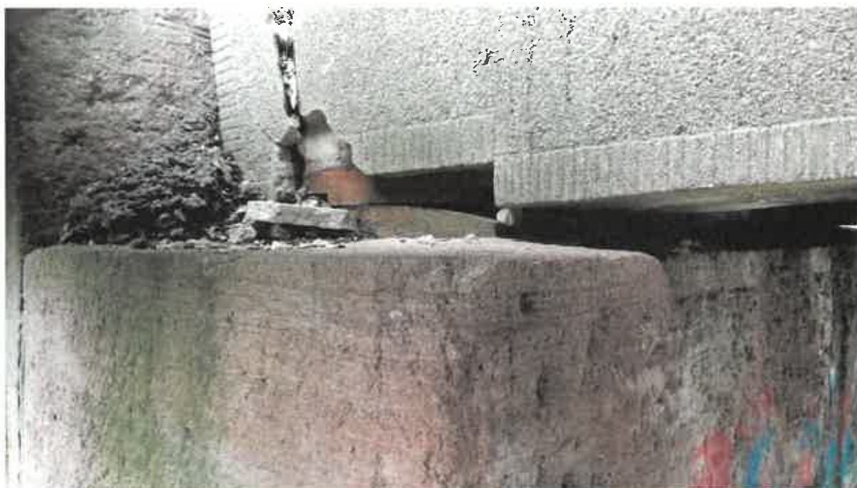
Obrázok 44: Ložisko na ľavobrežnej opore (I)
