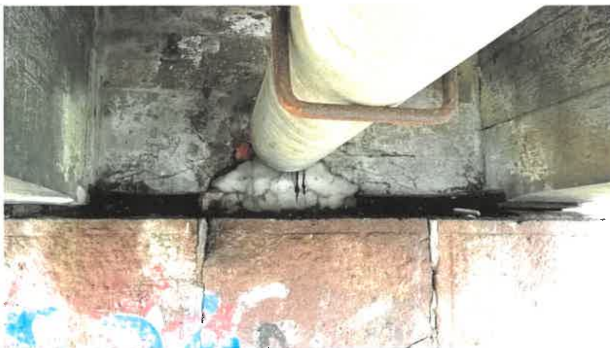
Obrázok 46: Úložný prah na ľavobrežnej opore
