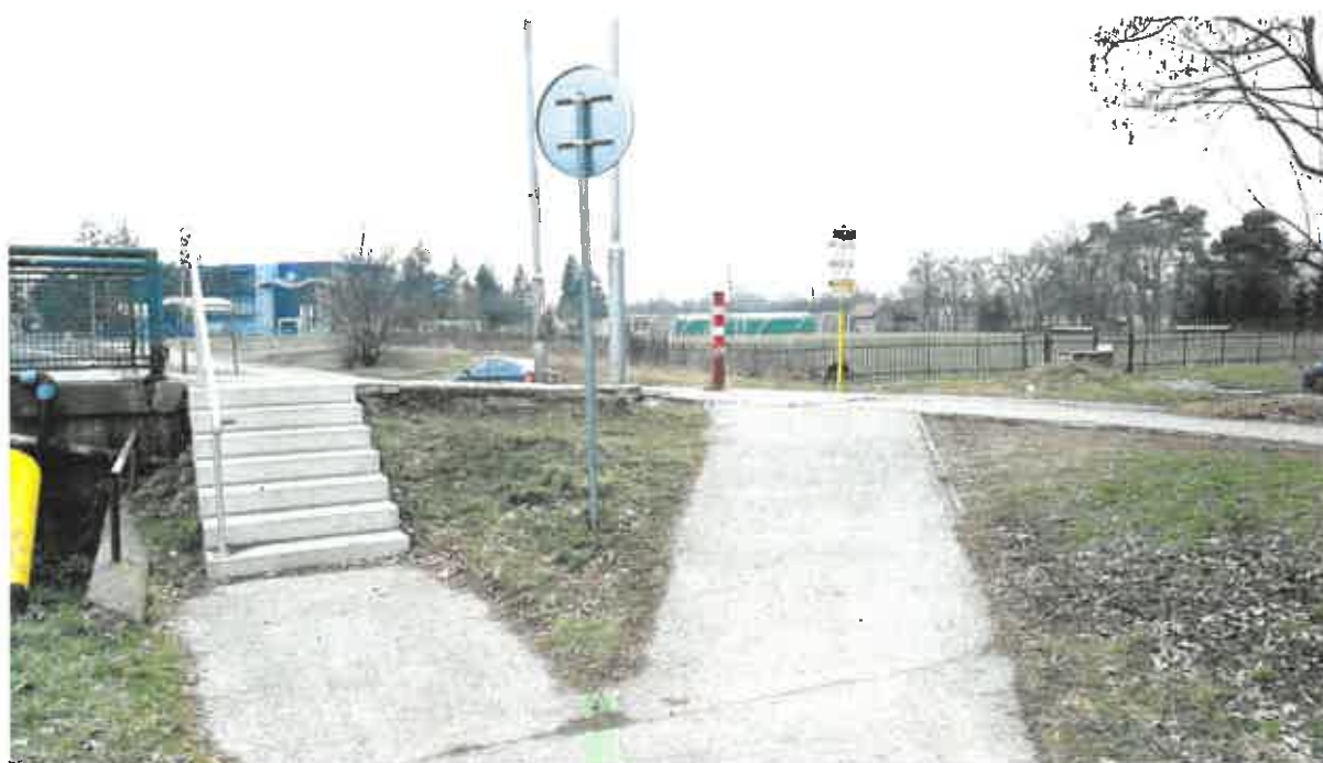
Obrázok 14: Predmostie - strana Nábrežie pri hydrocentrále (II)
