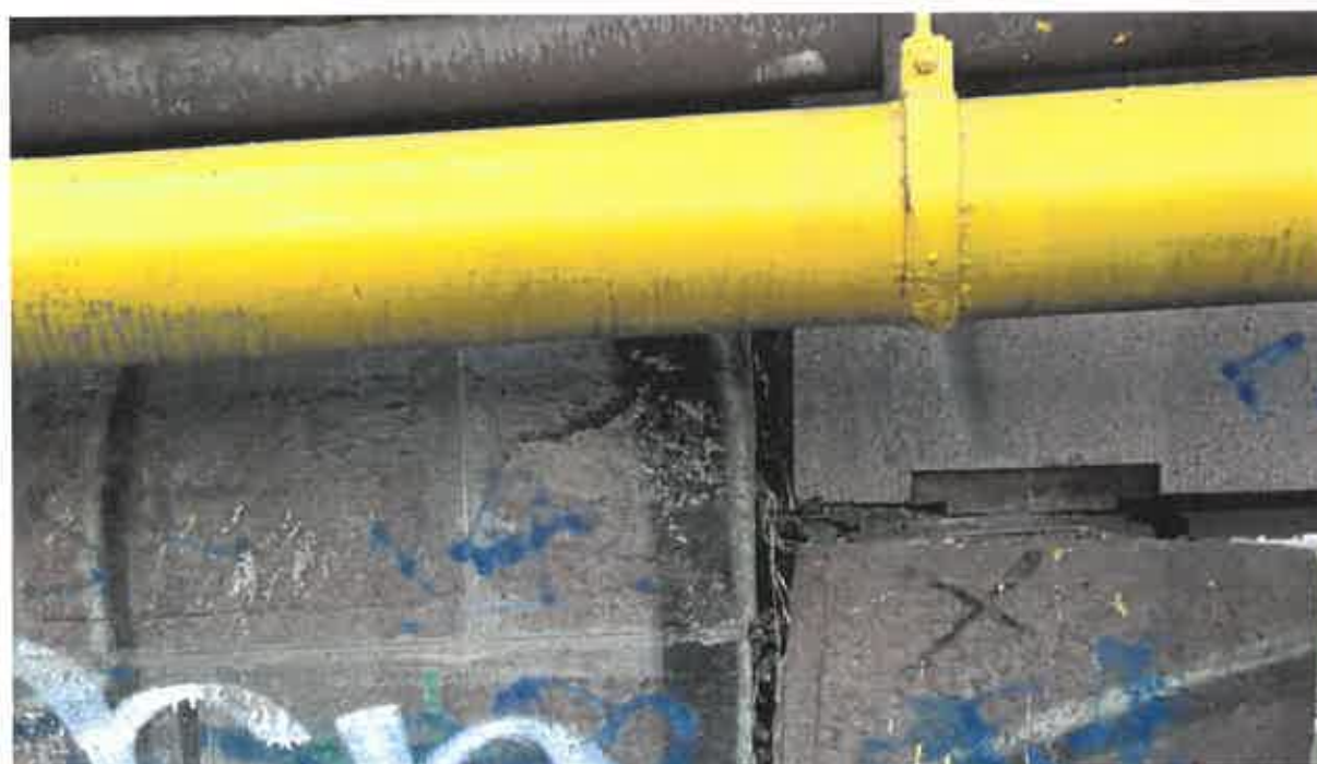
Obrázok 72: Dilatačná medzera – pravobrežná opora
