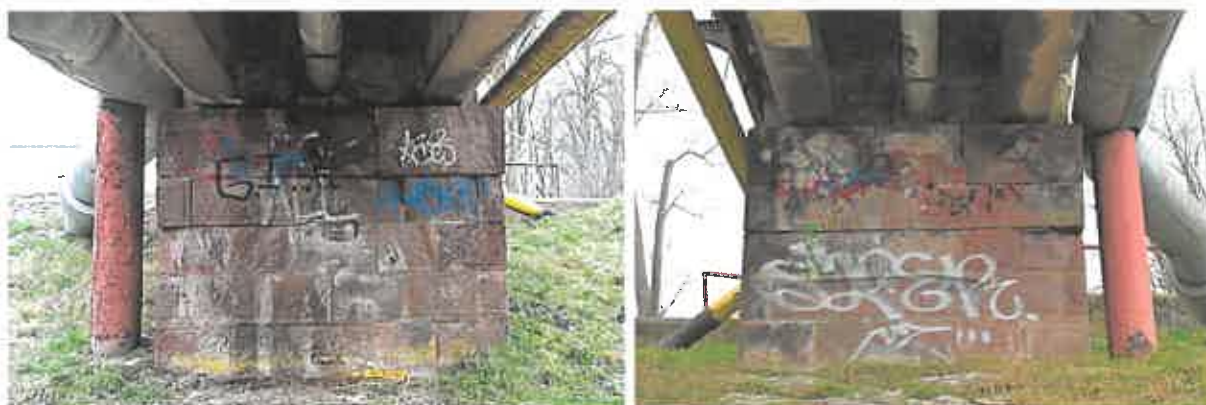
Obrázok 8: Pohľad na líce ľavobrežnej a pravobrežnej opory
