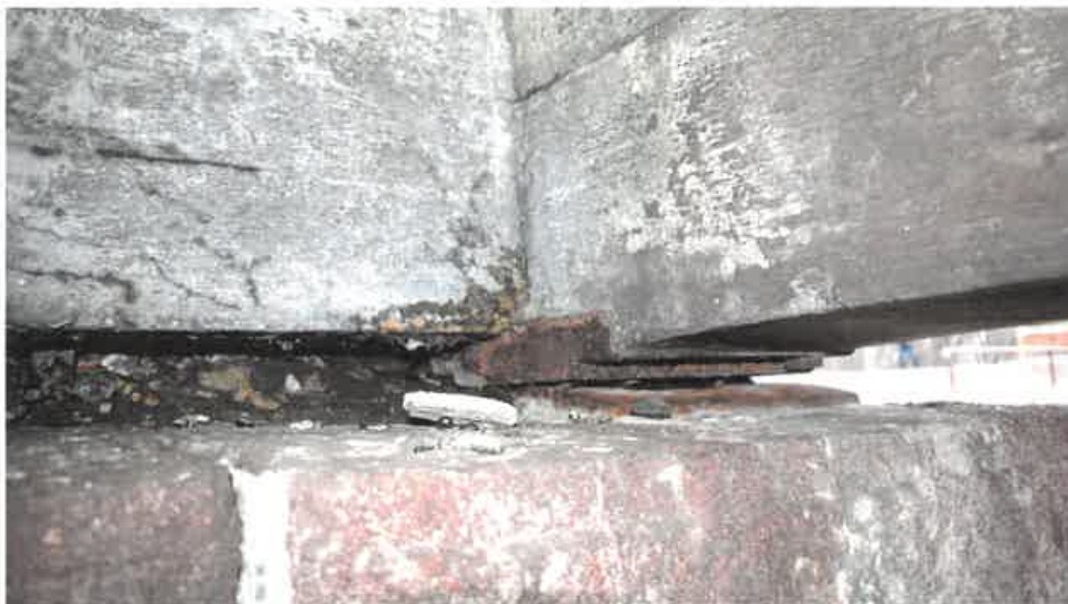
Obrázok 45: Ložisko na ľavobrežnej opore (II)
