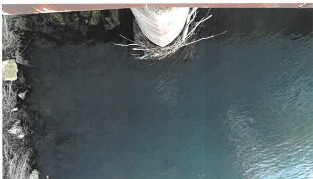
Obrázok 32: Pilier č. 1 – pohľad z lávky (návodná strana)
