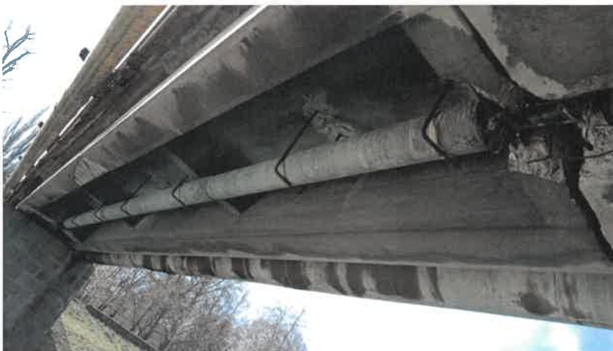
Obrázok 58: Hlavná nosná konštrukcia lávky (VIII)
