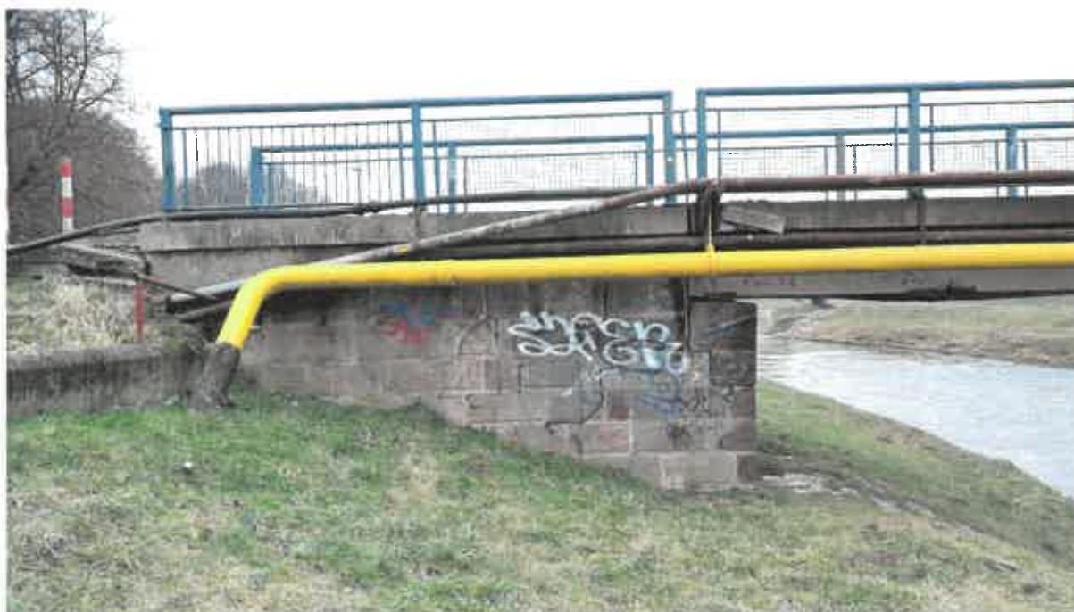
Obrázok 20: Pravobrežná opora s krídlom (strana výtoku)
