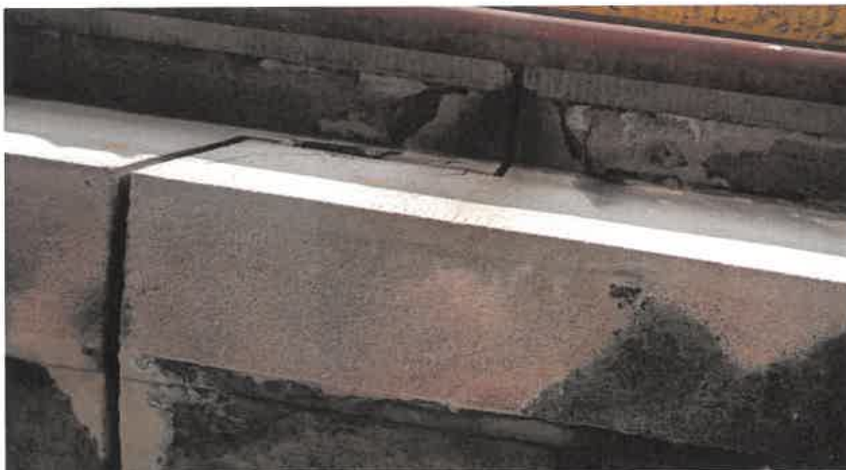
Obrázok 61: Kíb v nosnej konštrukcii – v blízkosti piliera č. 1 (III)
