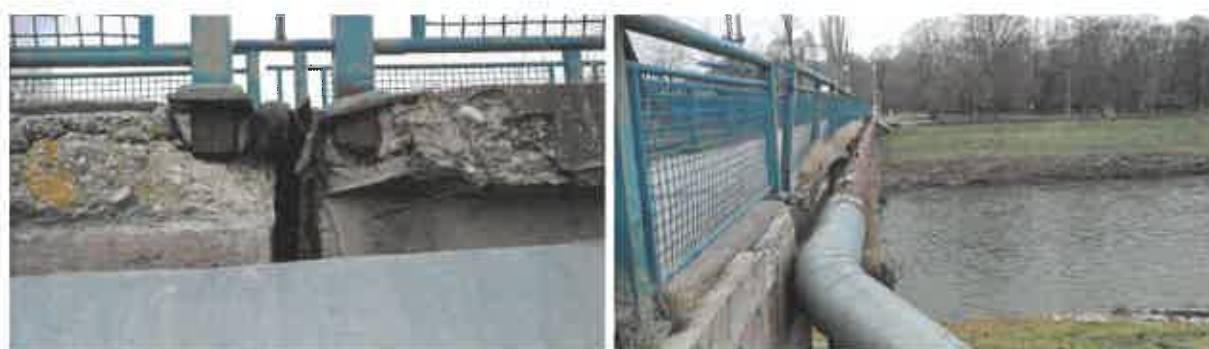
Obrázok 29: Zábradlie a jeho kotvenie
