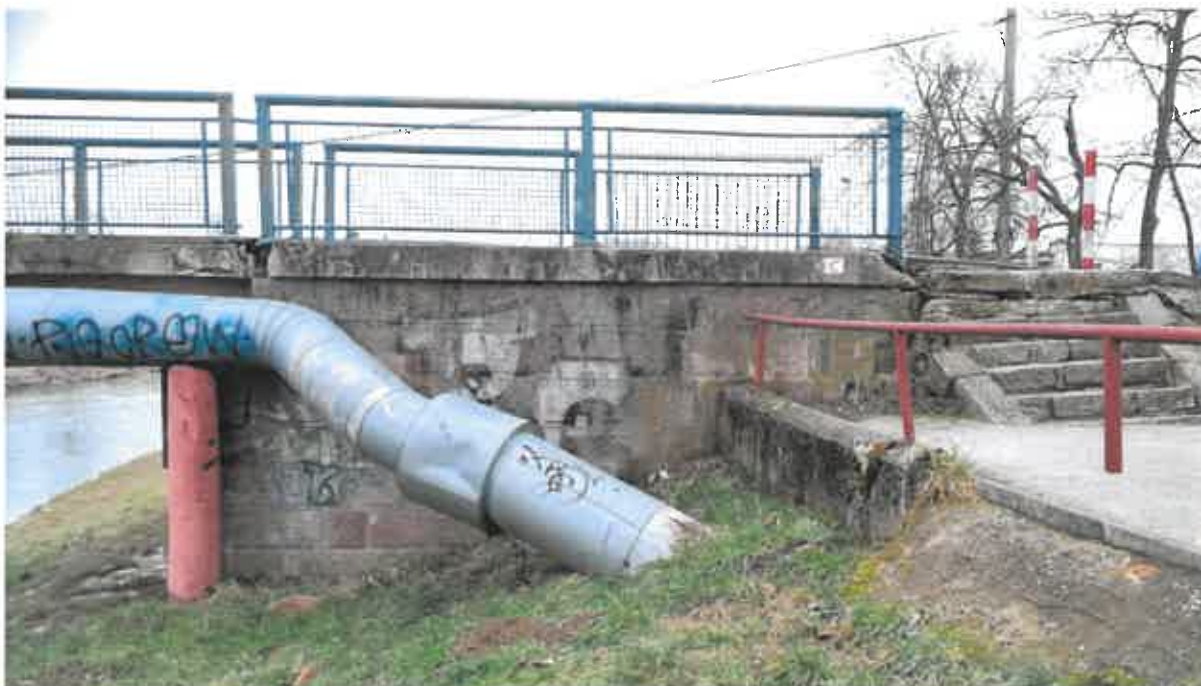
Obrázok 19: Pravobrežná opora s krídlom (strana vtoku)
