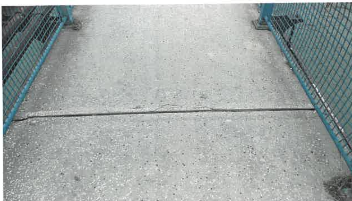
Obrázok 68: Mostný záver – kĺb v NK bližšie ku pilieru č. 1
