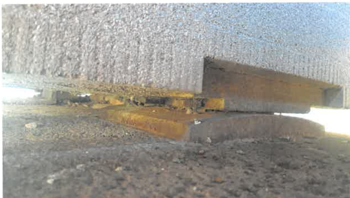
Obrázok 50: Ložisko na pilieri č. 2 (II)
