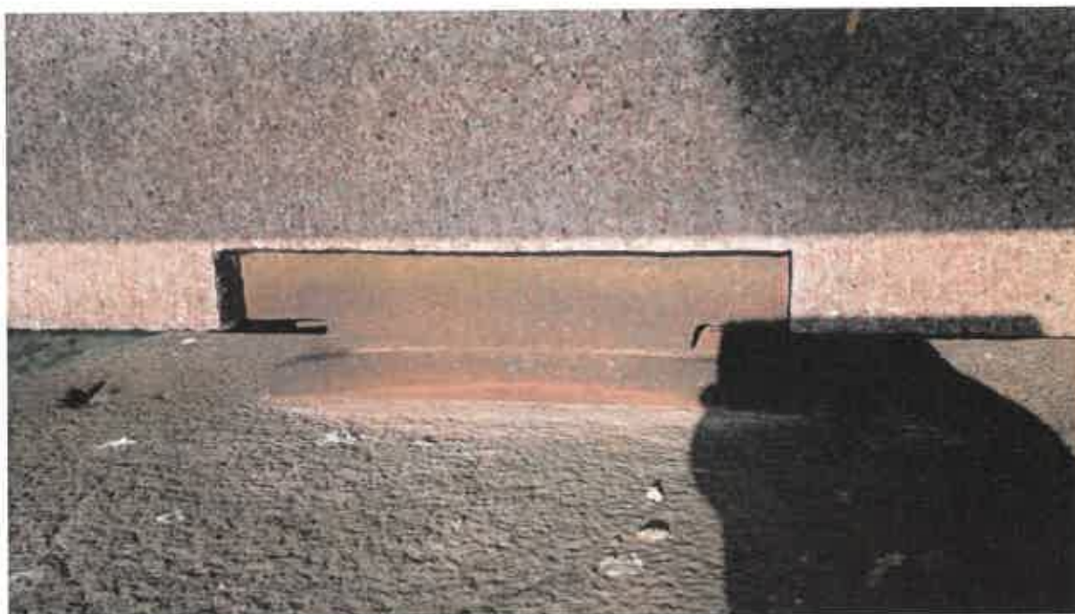
Obrázok 49: Ložisko na pilieri č. 2 (I)
