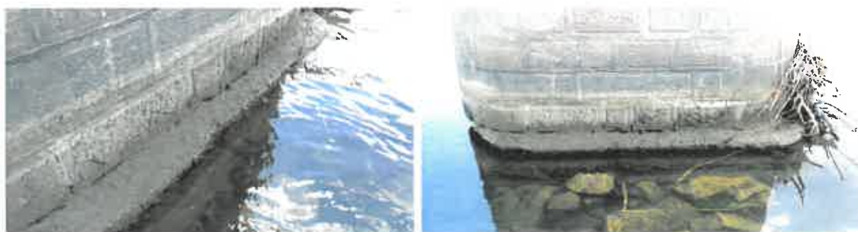
Obrázok 12: Pohľad na napojenie drieku piliera č. 2 na jeho základ
