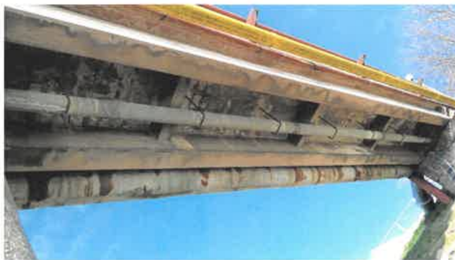
Obrázok 14: Pohľad na spodnú stranu hlavnej nosnej konštrukcie
