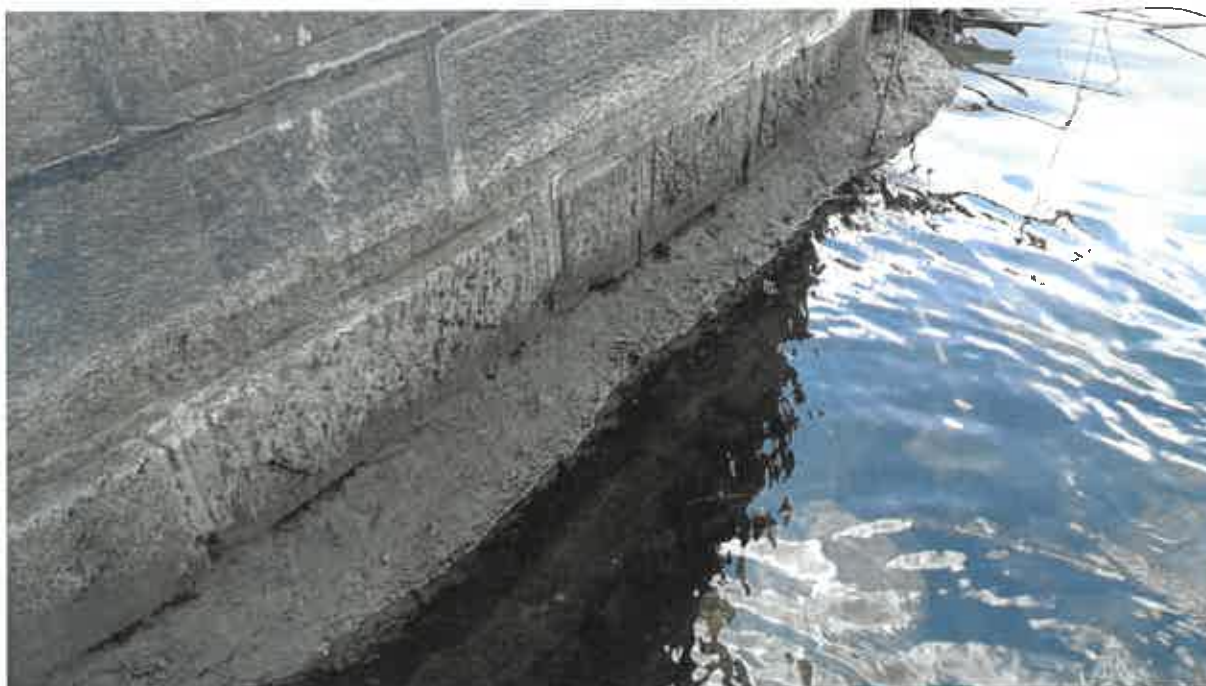
Obrázok 31: Pilier č. 1 – betónová vyrovnávacía vrstva medzi základom a prvou radou kvádrov (II)
