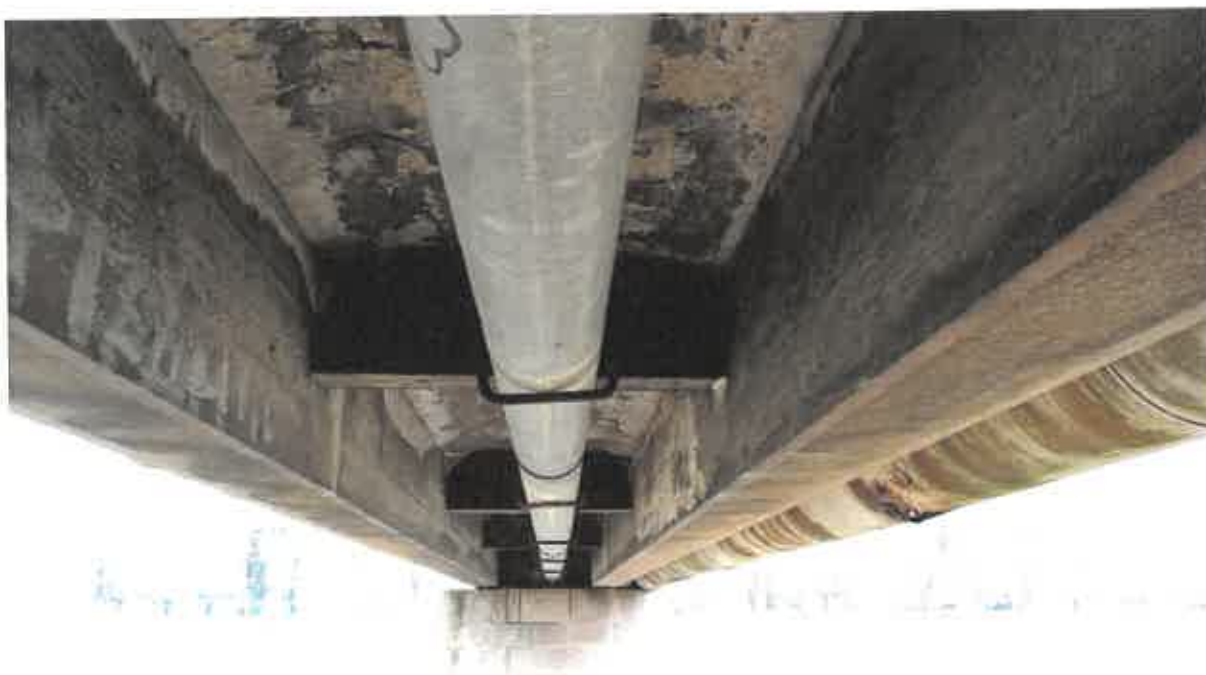
Obrázok 51: Hlavná nosná konštrukcia lávky (I)
