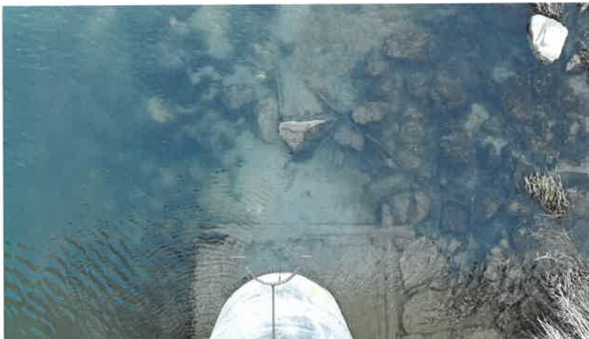
Obrázok 39: Pilier č. 2 – pohľad z lávky (povodná strana)
