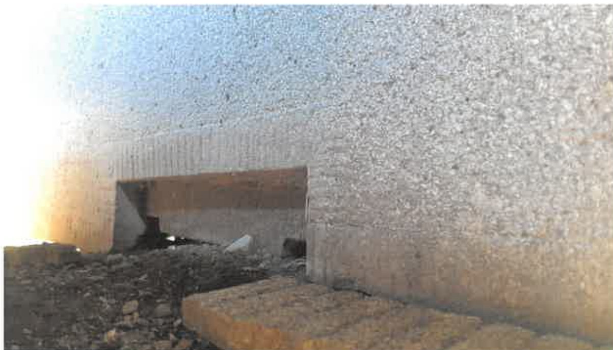
Obrázok 47: Ložisko na pilieri č. 1 (I)
