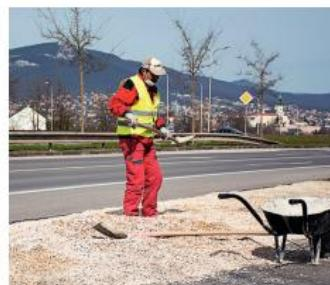
Rekonštrukcia spočíva vo vyfrézovaní poškodenej časti, odkopaní povrchu do hĺbky 60 cm, následnom položení prefabrikátov a osadením
