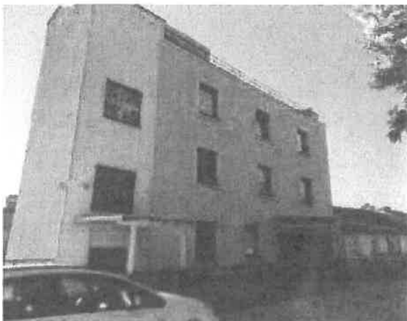
Obr. 2.2 Sklad z lodných kontajnerov po stavebných úpravách.
