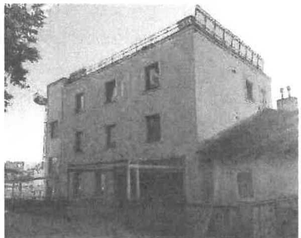
Obr. 2.2 Sklad z lodných kontajnerov po stavebných úpravách.
