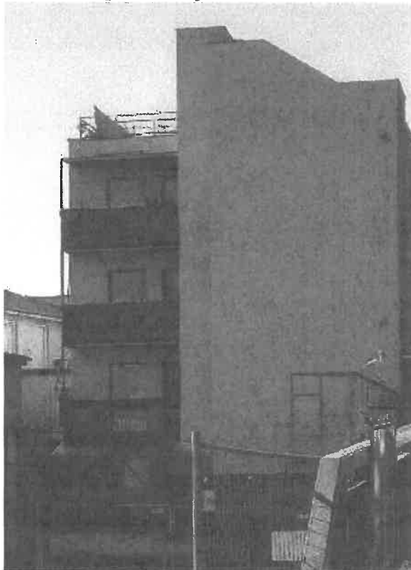
Obr. 2.3 Sklad z lodných kontajnerov po stavebných úpravách – pohľad na schodiskový trakt a balkóny.
