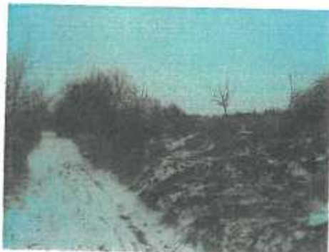
Pristup po nespevnenej komunikácii
