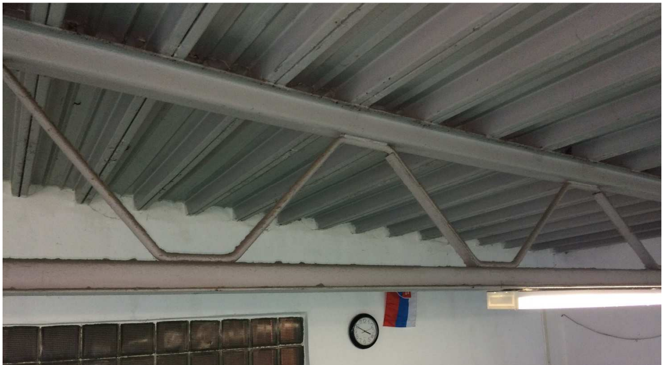
Obr. 2 Strešný väzník a plechobetónová doska.
