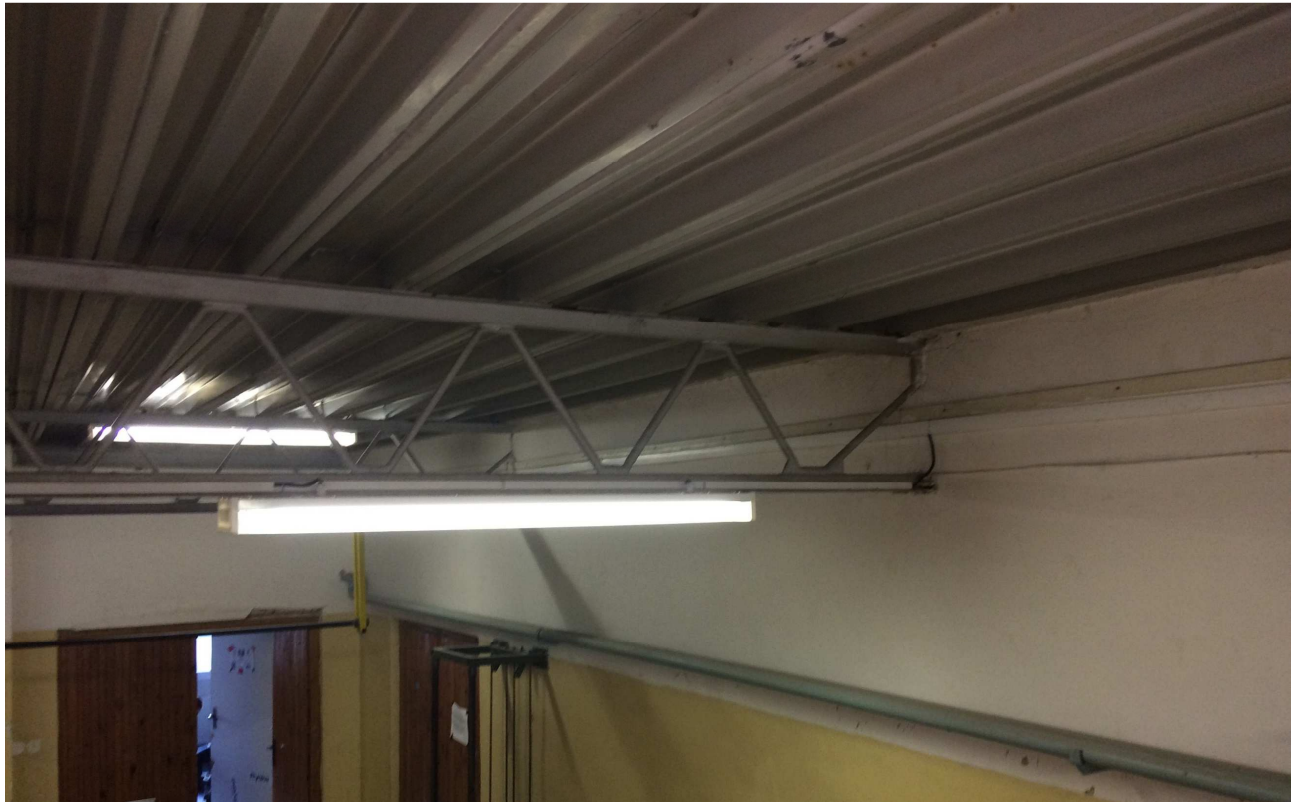
Obr. 3 Strešný väzník s rozponom 6,0 m.
