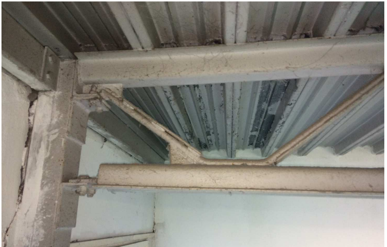
Obr. 1 Detail uloženia strešného väzníka s rozponom 12,0 m na stĺp a krajná tlačenná diagonála.
