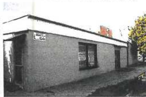
▼ Pohľad zo dvora areálu na budovu Šport centra - východný
