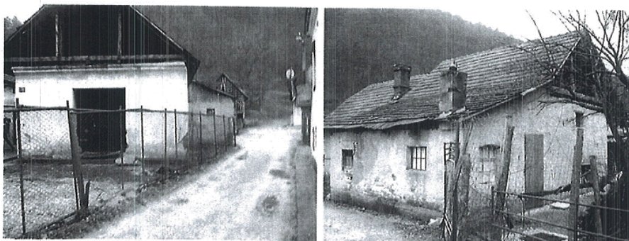
Hospodárska budova na p.č. 752 – príslušenstvo k domu s.č. 157
