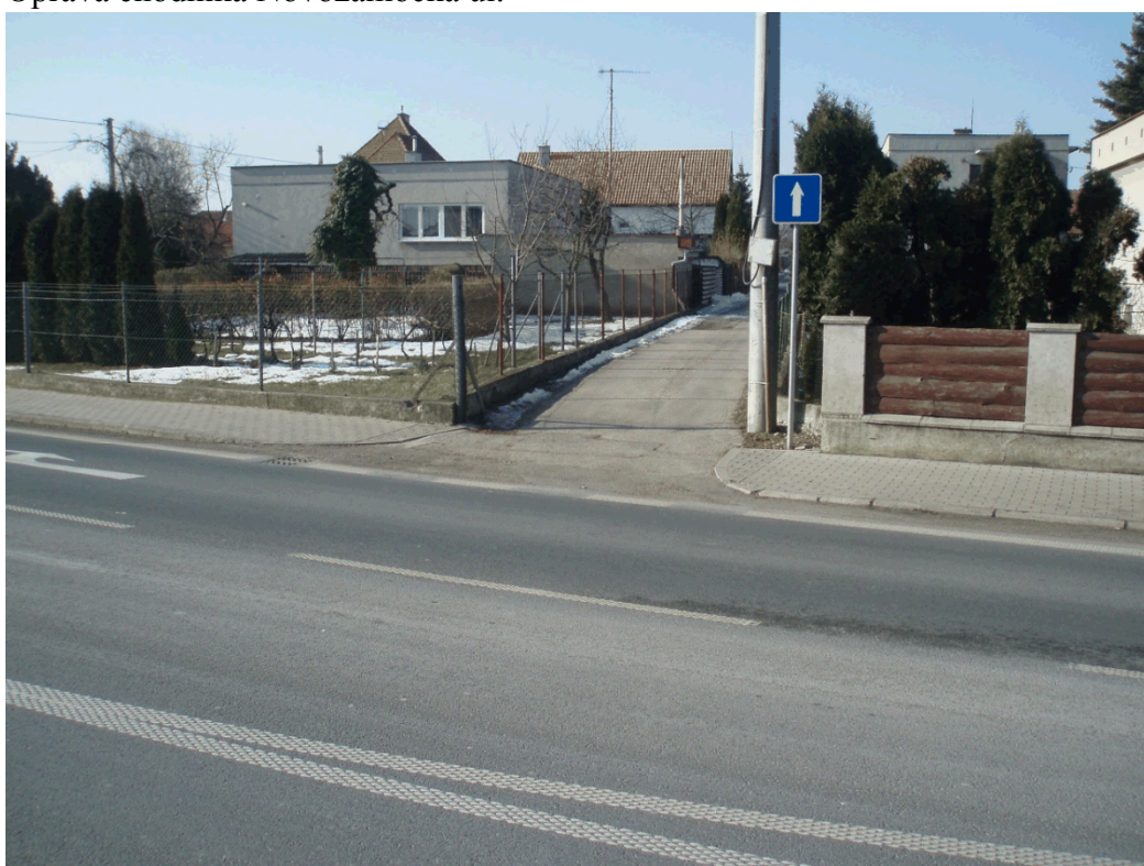
Oprava chodníka Novozámocká ul.
